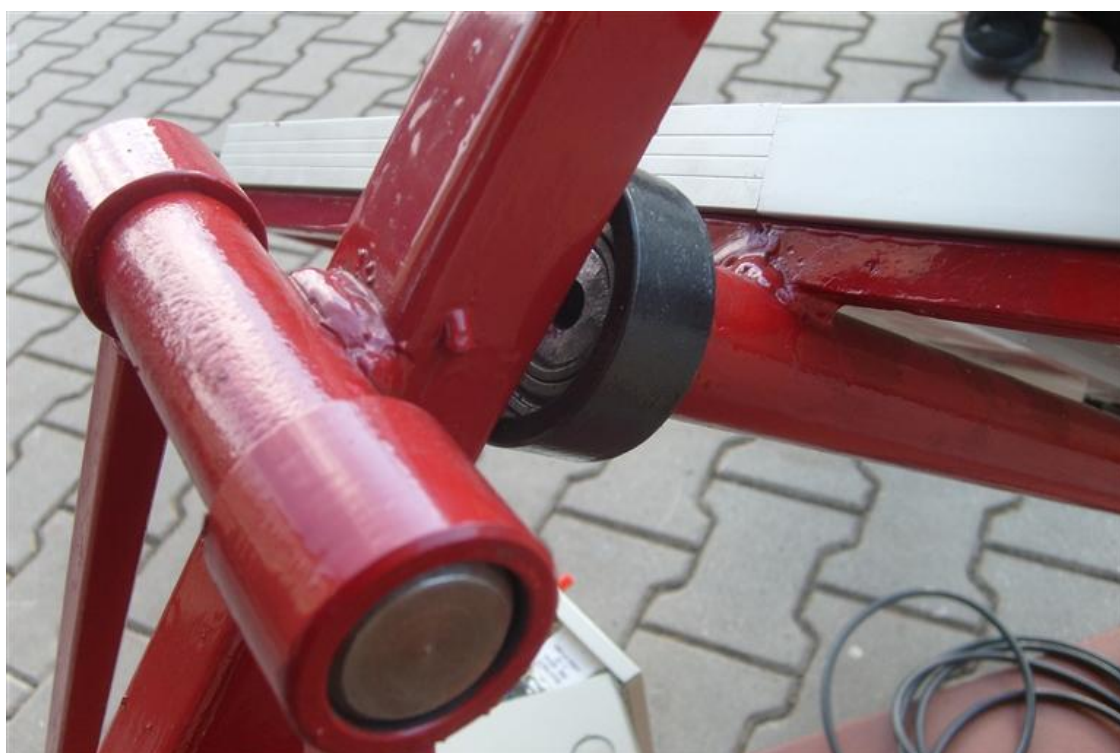
Obr. 21 – Detail ložiska natáčecí konstrukce
