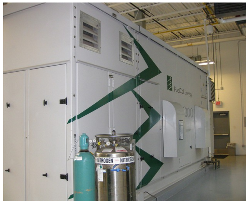
Obr.2 Vodíkový palivový článek typu MCFC o výkonu 250kW
