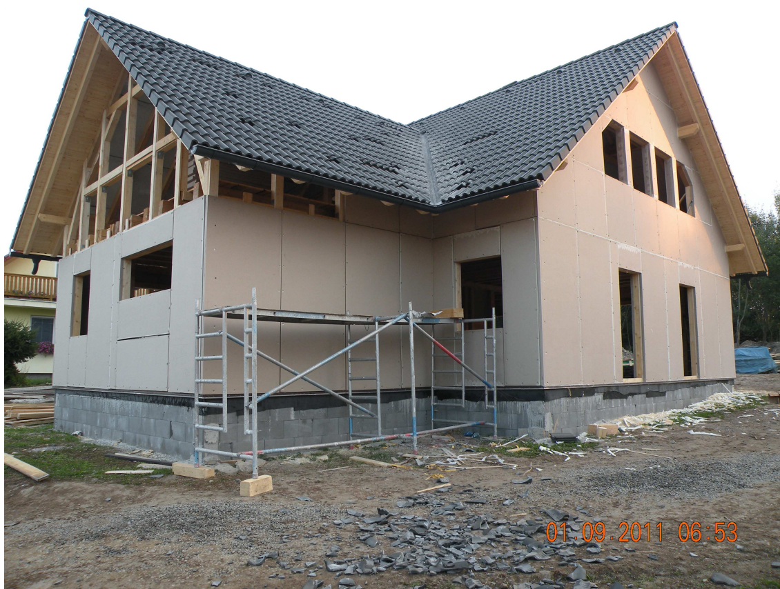
Průběh opláštění ekopanelem 2.NP
