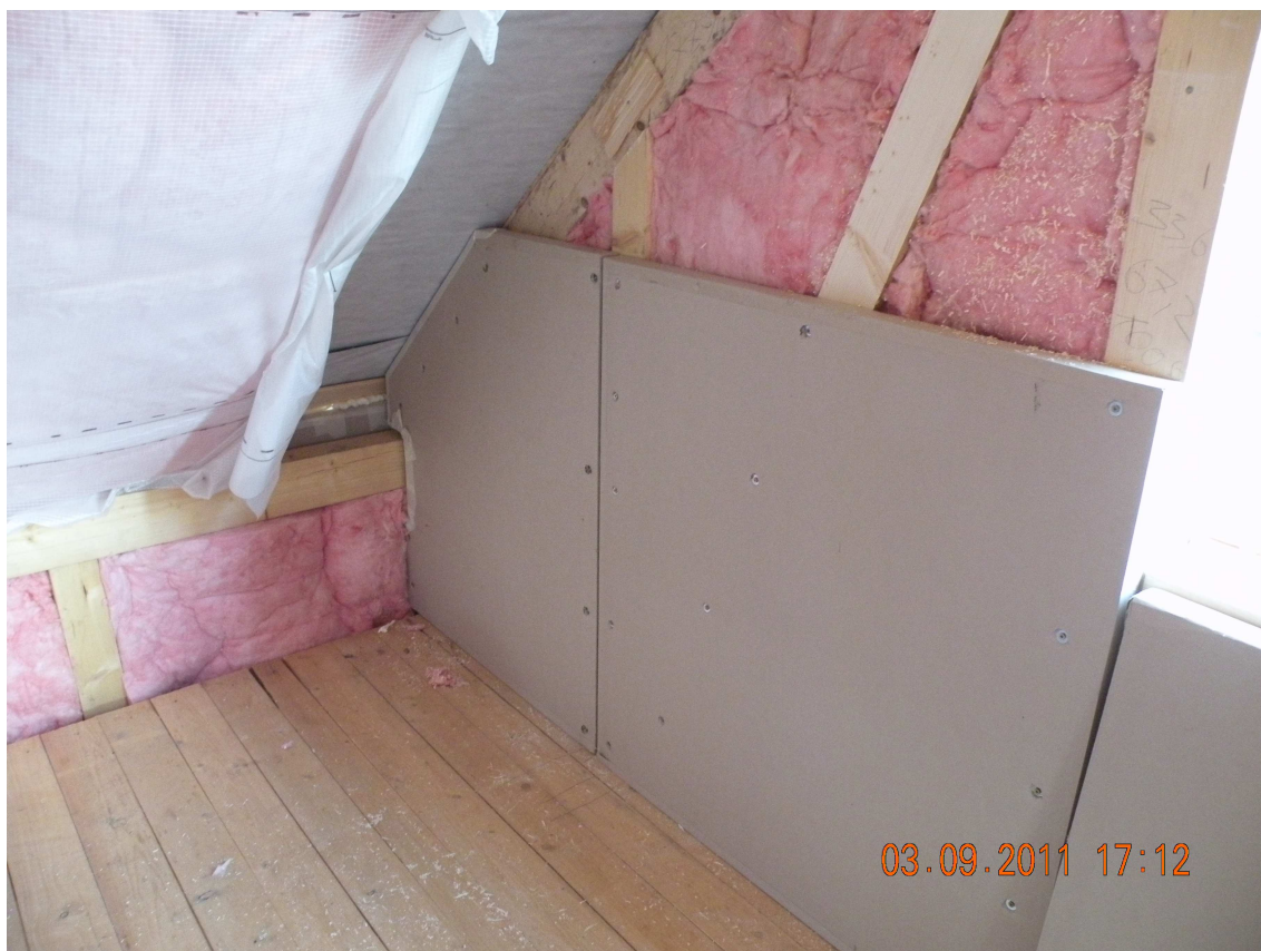
Montáž ekopanelu uvnitř domu
