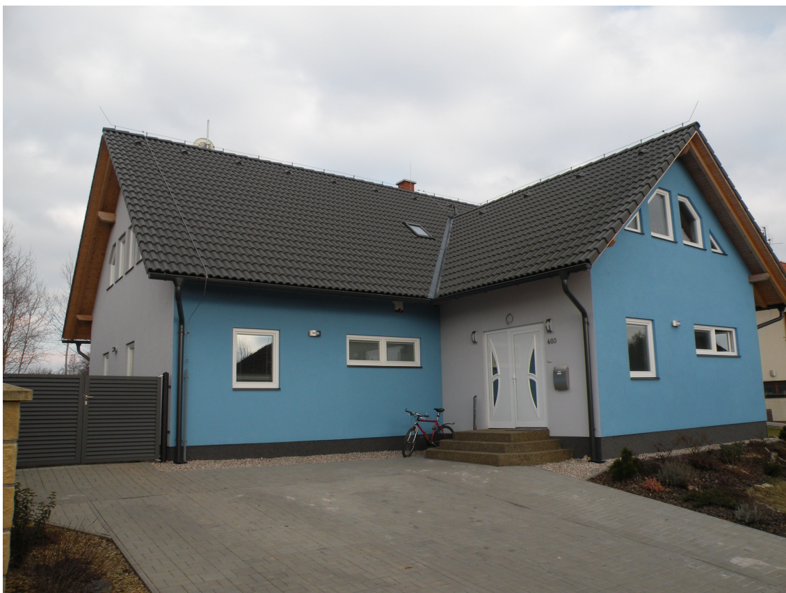
Pohled na západní stranu dokončeného domu
