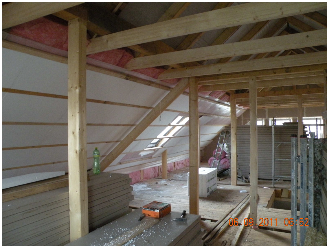
Zateplení polystyrenovými deskami v podkroví
