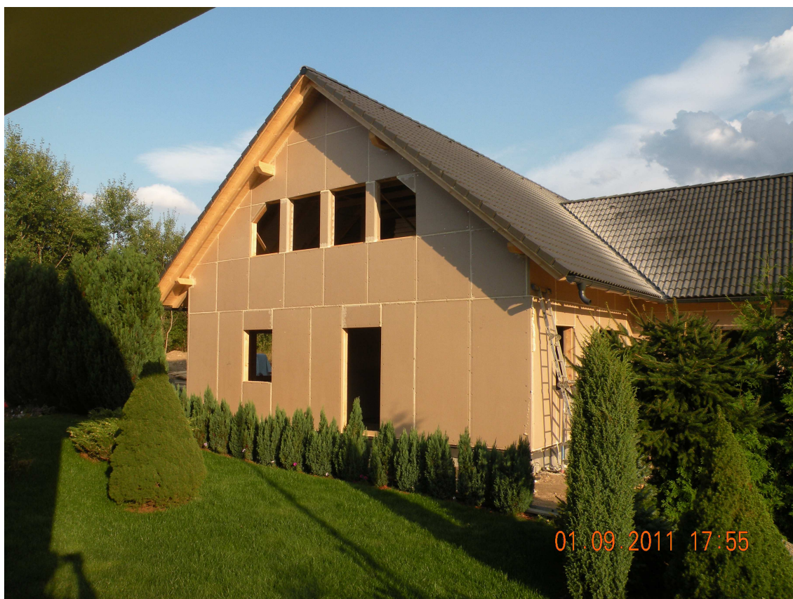
Opláštění ekopanelem celého domu
