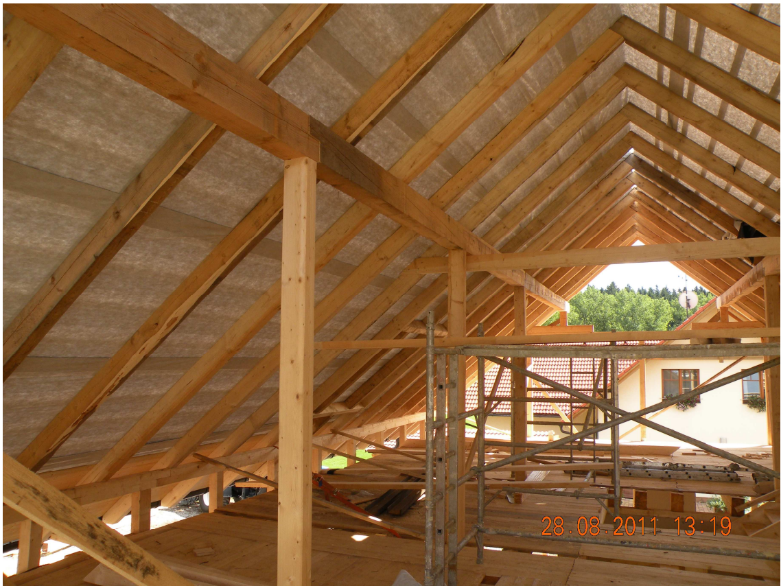
Smontovaná nosná konstrukce – vnitřní pohled na 2.NP
