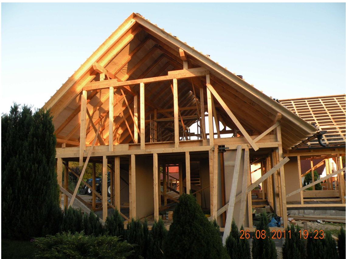
Smontovaná nosná konstrukce
