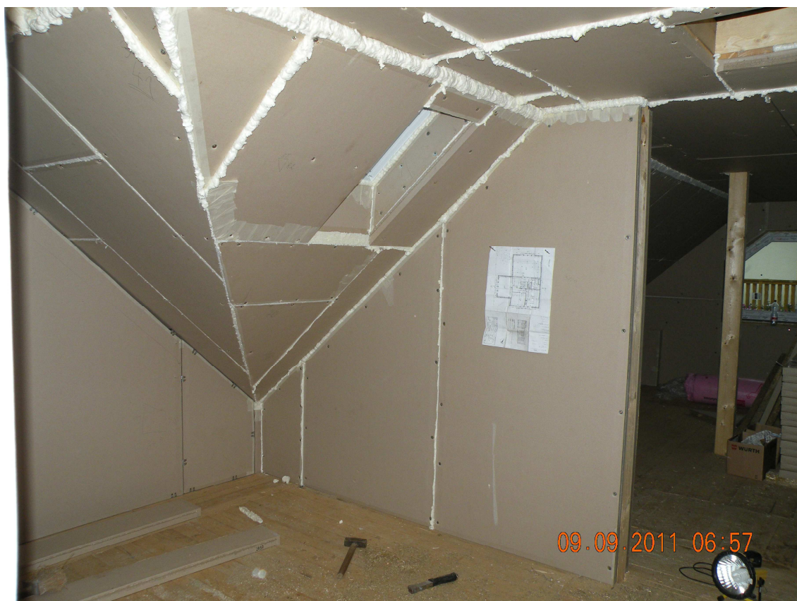
Vyplnění spojů mezi ekopanely
