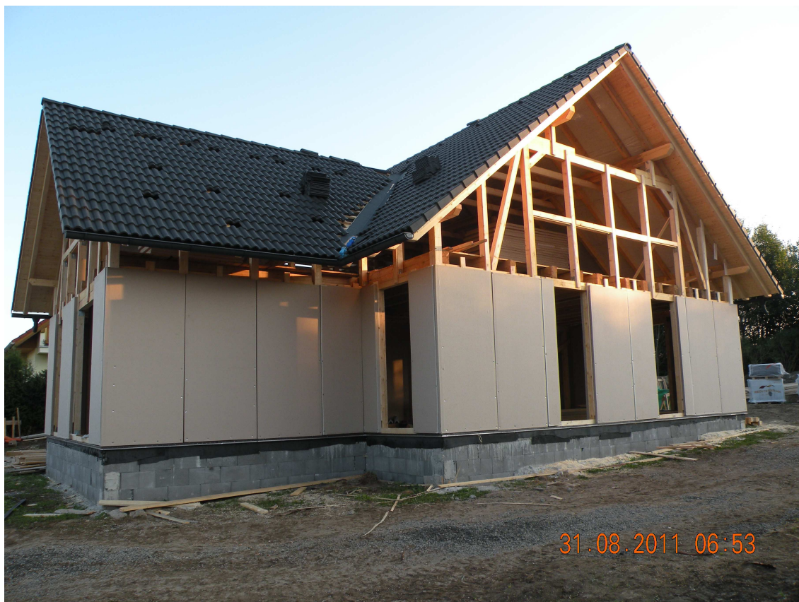
Průběh opláštění ekopanelem 2.NP
