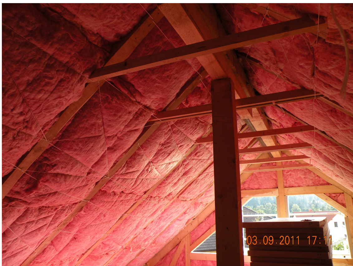
Montáž ekopanelu uvnitř domu
