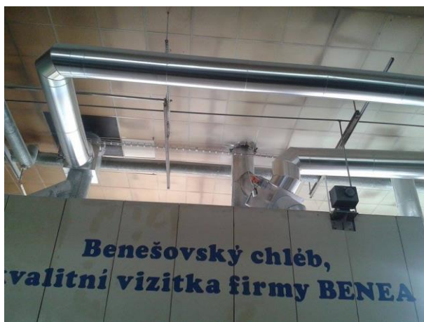
Obr. 6 a 7: Klapky na odvodu spalin z chlebové pece [6]
