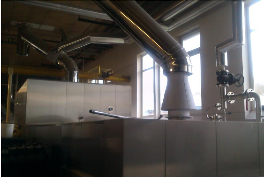
Obr. 10: Odvod spalin z nové pece na pečivo [6]
