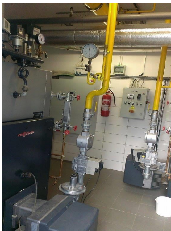
Obr. 2: Nová kotelna s plynovými parními kotli [6]
