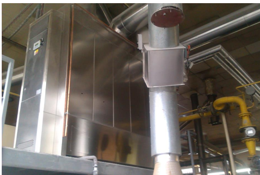
Obr. 9: Klapky a EkoBlok u chlebové pece [6]
