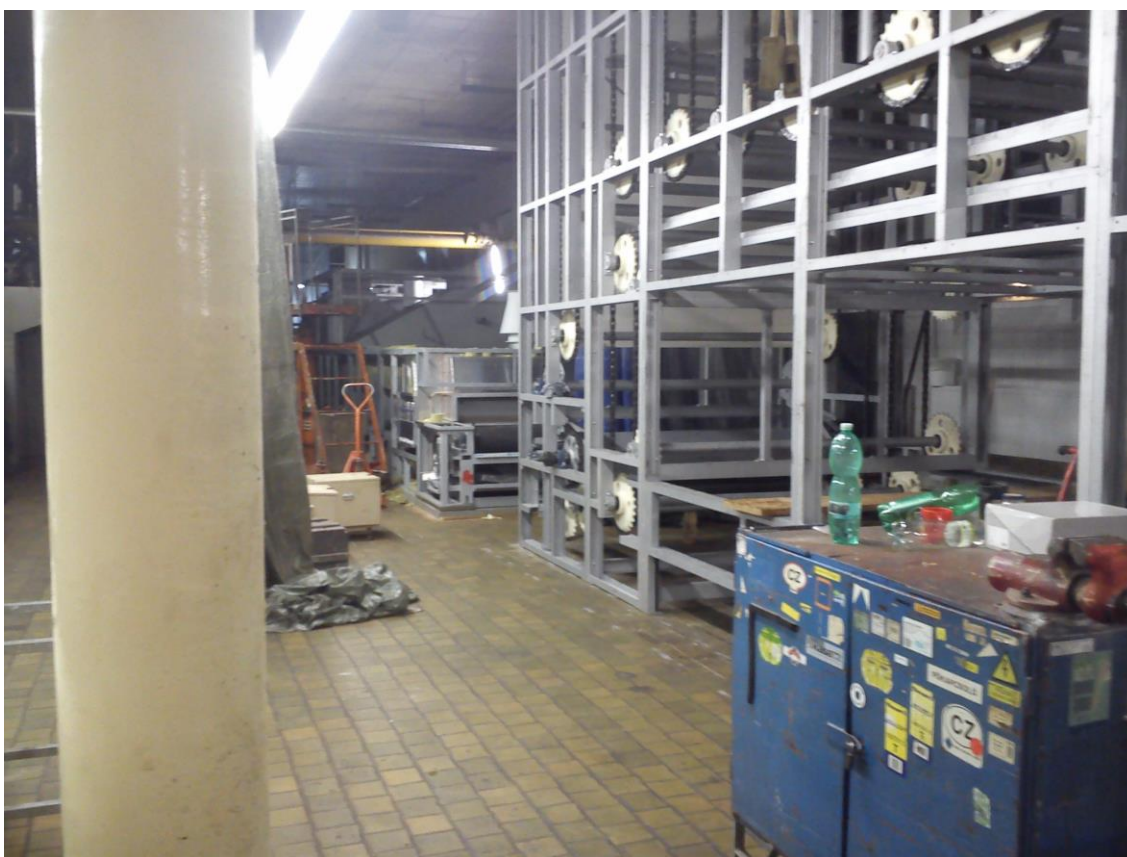
Obr. 15: Stavba nové pece na pečivo [6]
