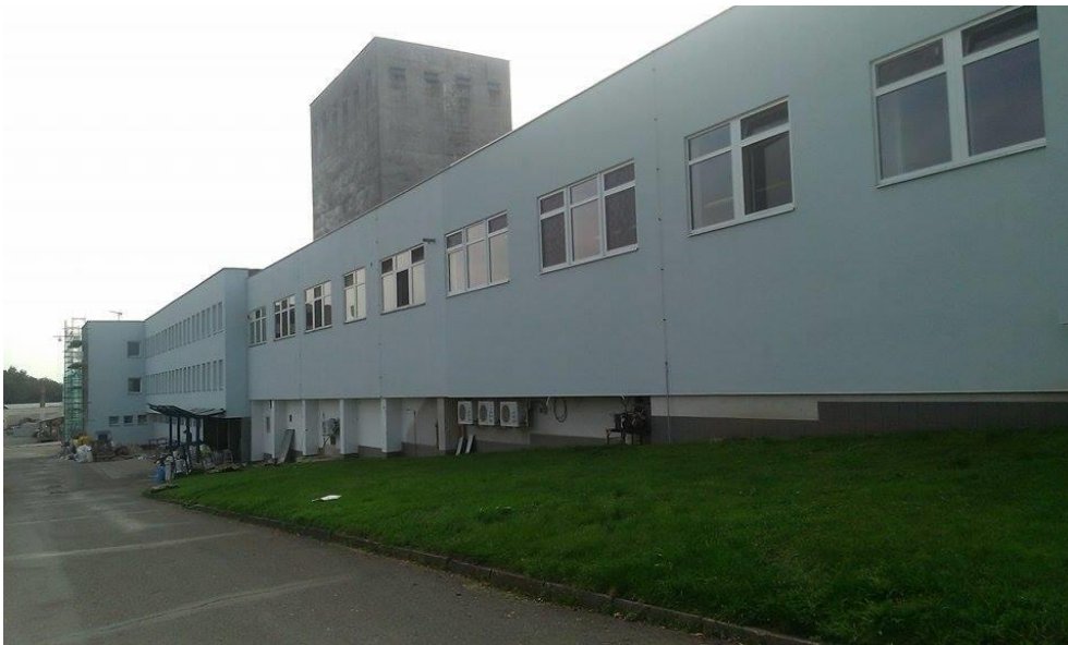
Obr. 13: Zateplená provozní budova a budova cukrárny [6]
