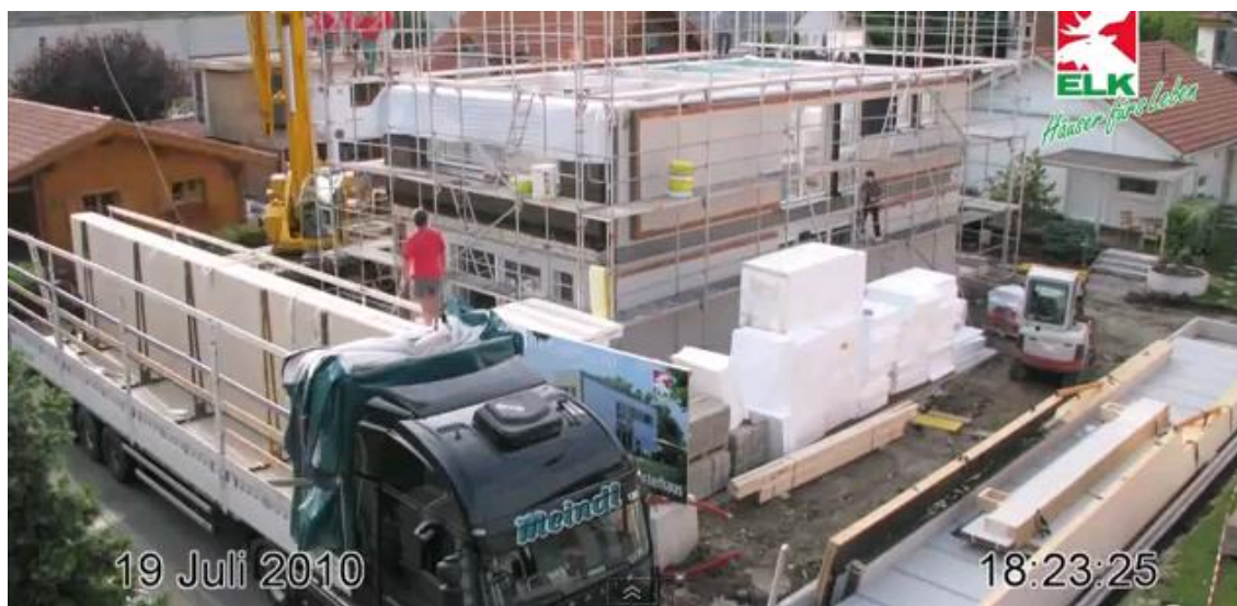
Obr. 31: Stav montáže stejný den odpoledne
