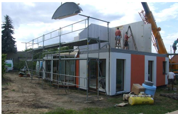
Obr. 26: Montáž druhého podlaží
