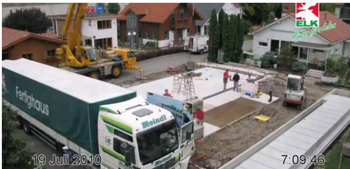
Obr. 30: Začátek montáže pasivního domu
