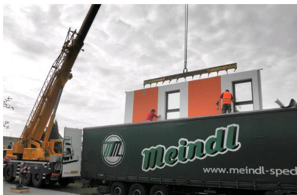
Obr. 25: Vykládání domu jeřábem
