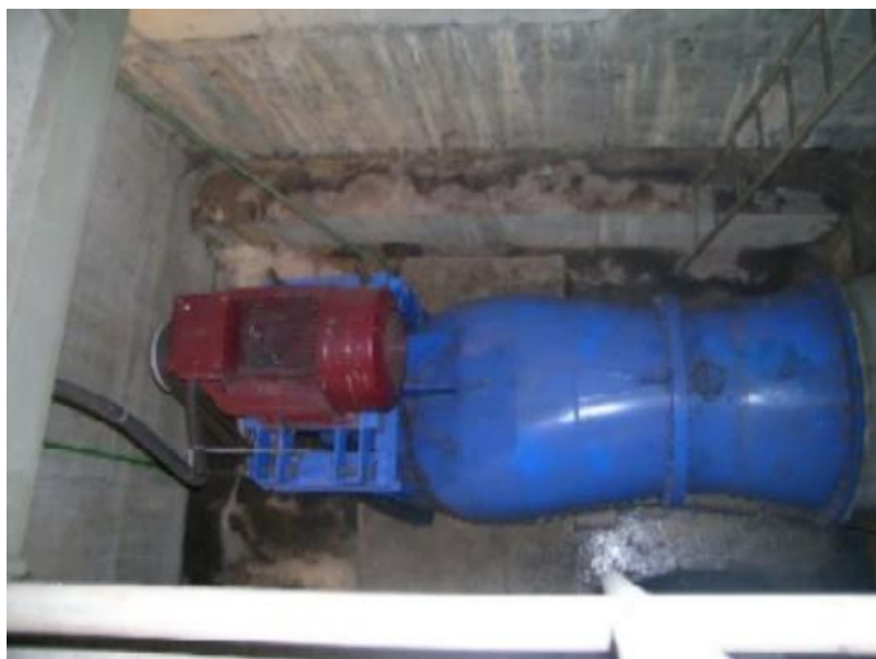
Obr. 11: Strojovna MVE - pohled na turbínu a generátor
