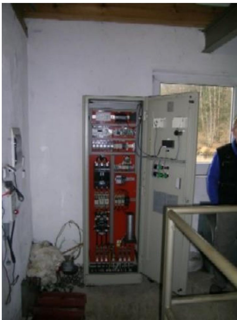
Obr. 10: Strojovna MVE - pohled na rozvaděč
