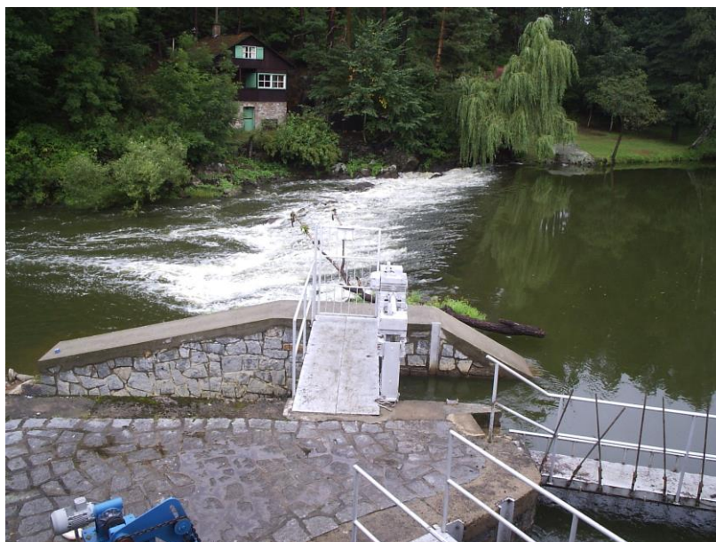
Obr. 9: Pohled na jez a jalovou propust
