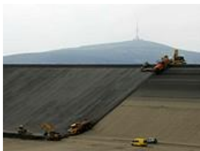
Obr. 4: Oprava horní nádrže
