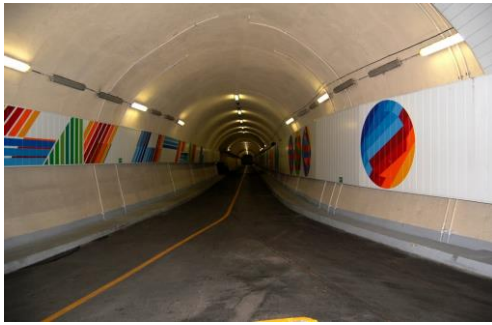
Obr. 15: Tunel vedoucí do kaverny
