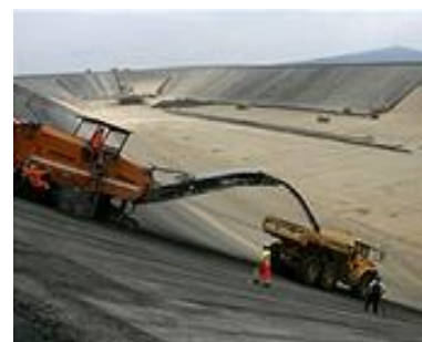
Obr. 6: Oprava horní nádrže
