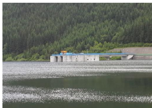
Obr. 26: Hráz dolní nádrže
