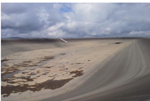
Obr. 23: Vypuštěná horní nádrž
