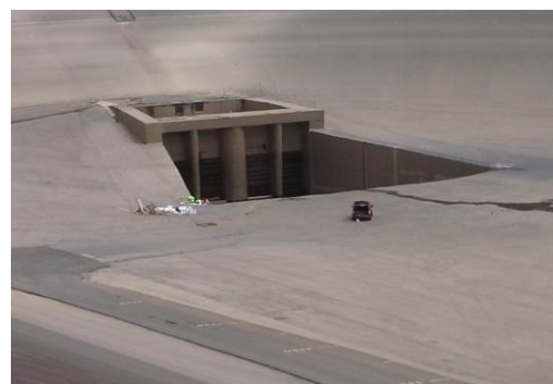
Obr. 24: Vypuštěná horní nádrž
