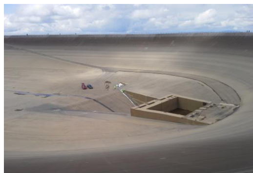
Obr. 22: Vypuštěná horní nádrž
