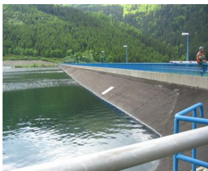
Obr. 8: Hráz dolní nádrže
