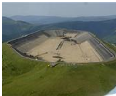
Obr. 5: Celkový pohled na rekonstrukci nádrže
