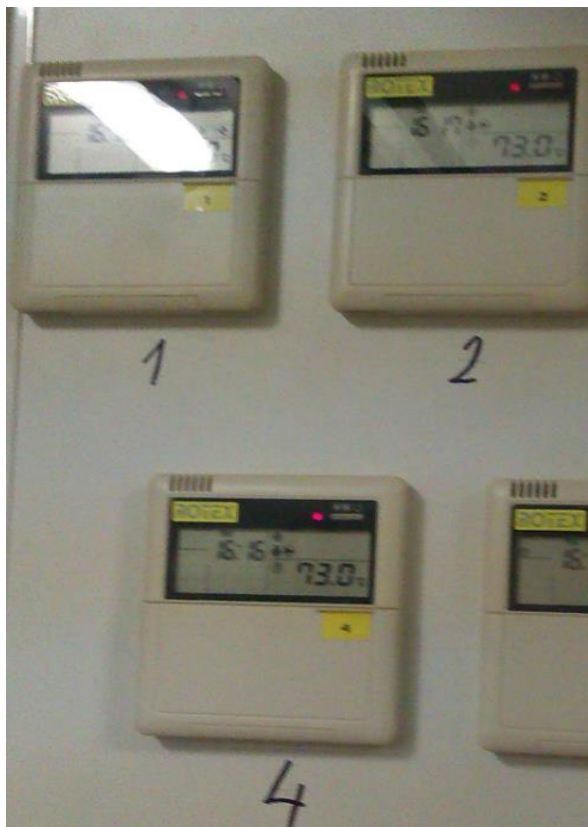
Obr. 15: Odečet teploty vody na výstupu z tepelných čerpadel [10]
