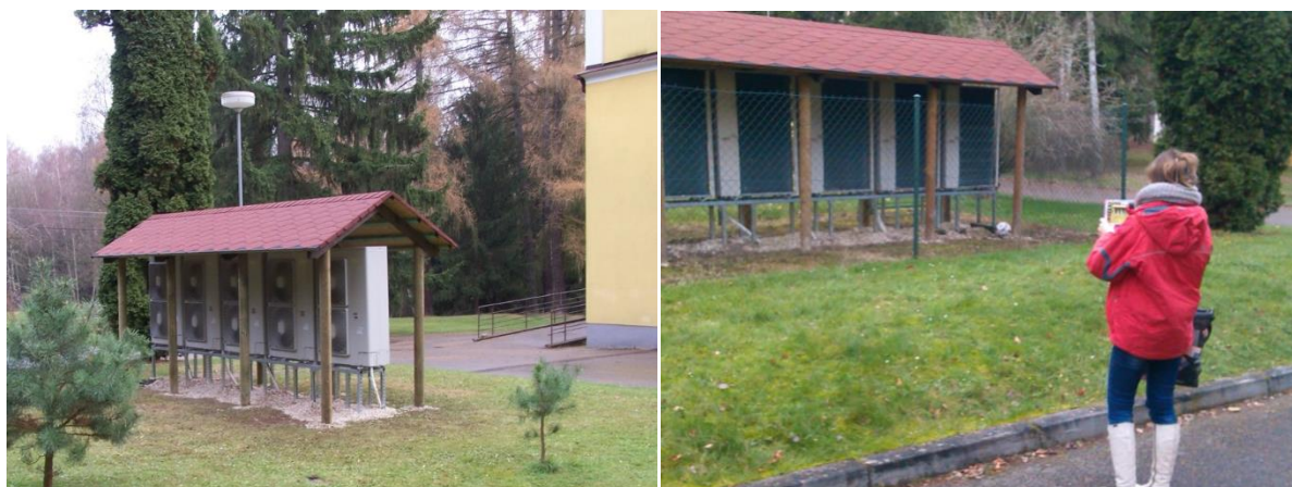
Obr. 10 a 11: Umístění venkovních jednotek ROTEX [9], [10]
