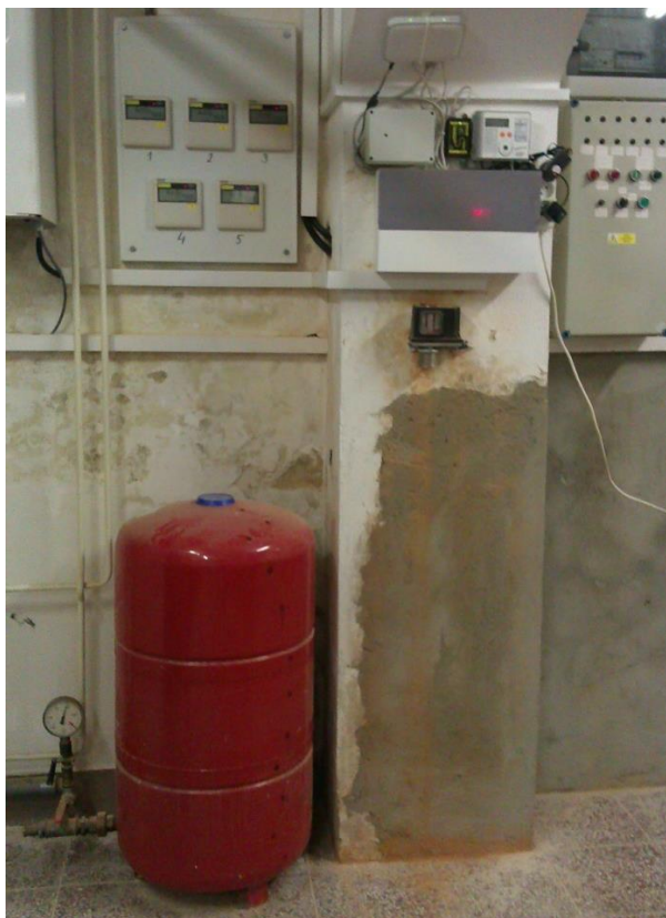
Obr. 14: Expanzní nádoba, MaR systém [10]
