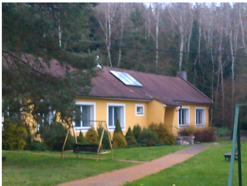
Obr. 7: Budova terapeutického a vzdělávacího pracoviště [10]
