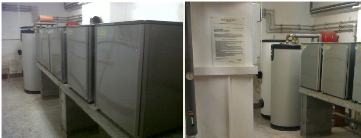
Obr. 12 a 13: Umístění vnitřních jednotek ROTEX [9], [10]
