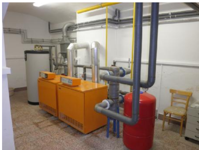
Obr. 8: Původní plynové kotle [8]
