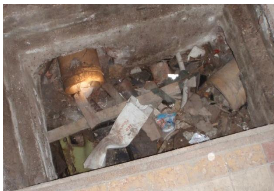
Obr. 8: Současný stav kanalizace v objektu
