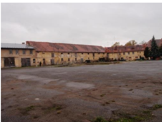
Obr. 9: Pohled na nádvoří uprostřed areálu
