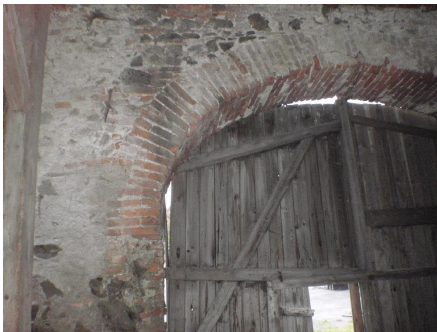
Obr. 7: Detail vstupní brány do jedné z budov
