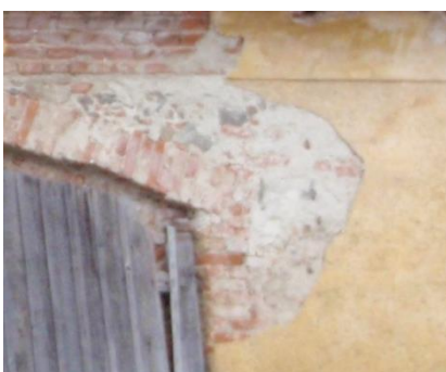
Obr. 11: Opadaná omítka u brány do jednoho z objektů
