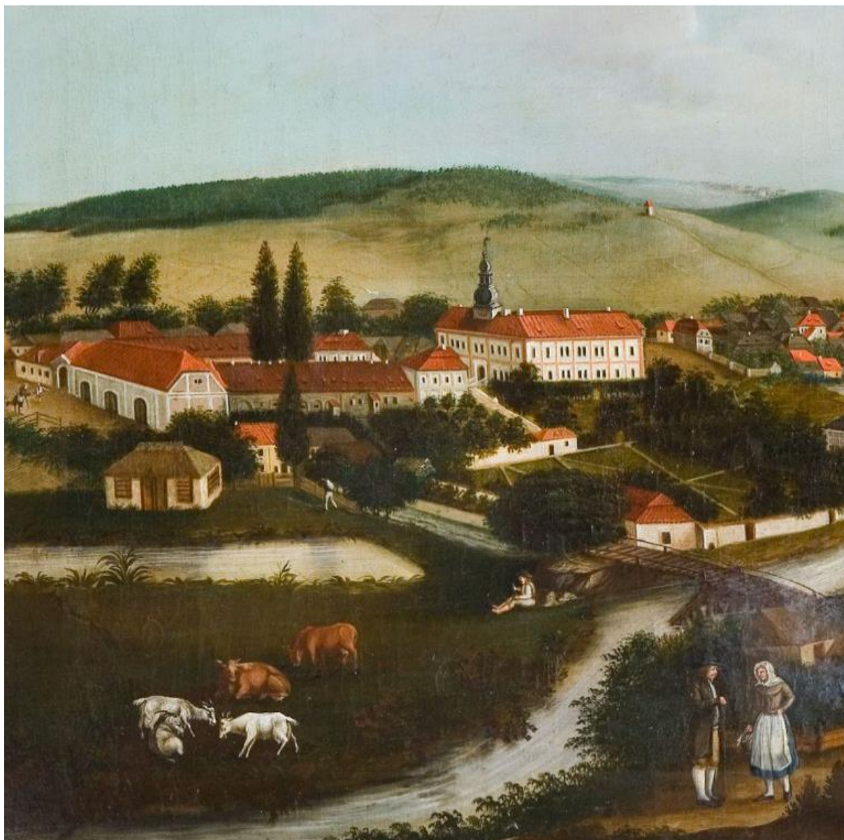
Obr. 6: Pohled z bohušovské stráně na statek (vlevo) a zámek, začátek 18. století
