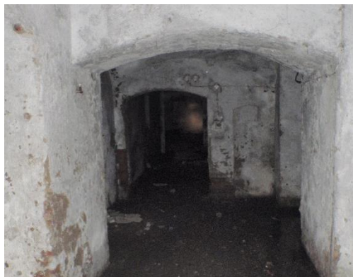
Obr. 16: Další z podzemních chodeb
