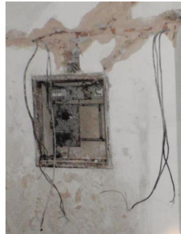
Obr. 10: Stav elektroinstalace v objektu po nájezdu sběračů kovů
