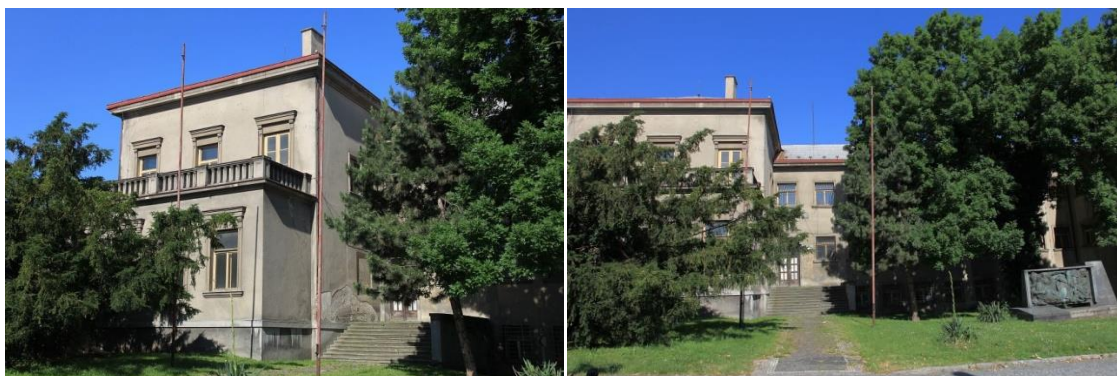
Pohledy z ulice Sokolská (východ)
