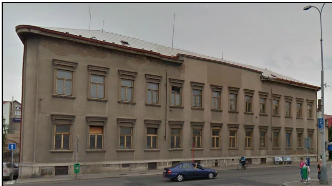
Obrázek 1: Pohled na budovu z náměstí Republiky
