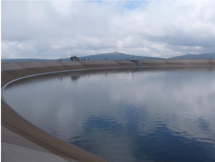
Příloha č.3 – Pohled na horní nádrž (v pozadí hora Praděd)
