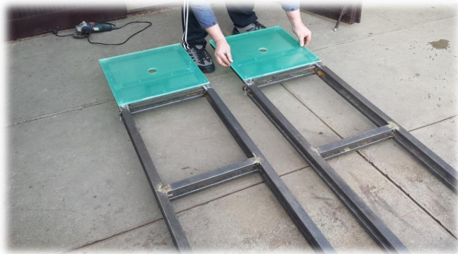
Obr. 8 – Rámy terčů před pozinkováním
