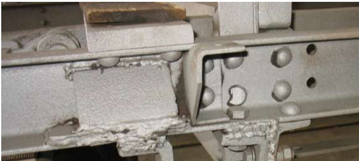
Obrázek 8: Oprava poškození profilu na skutečném rámu
