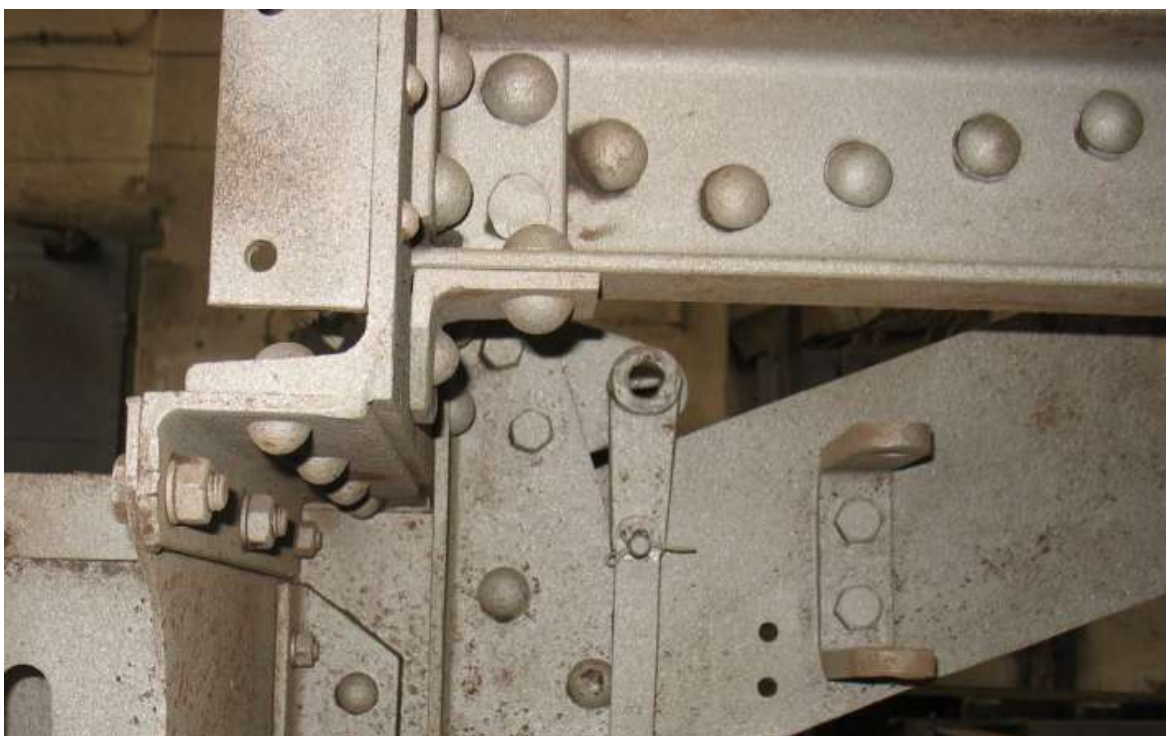
Obrázek 1: Detail nýtovaného spoje skutečného rámu
