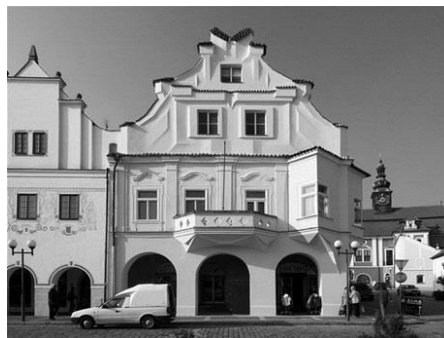
II Fárův dům v Pelhřimově
