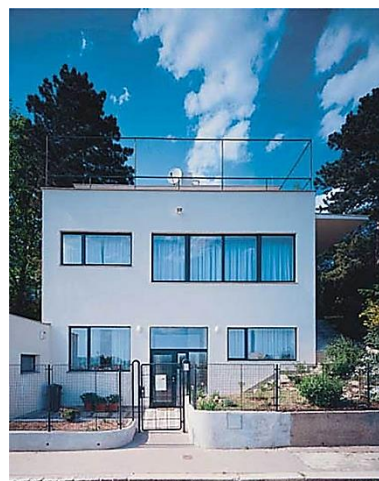
V Dům Janák po roce 1998, čelní pohled
