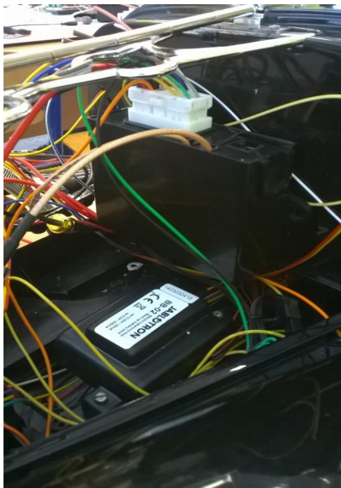
Obr. 14 Řídící jednotka, záložní baterie
