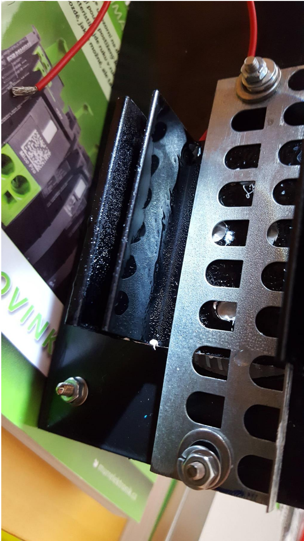
Příloha 6 - Zkapalněná vzdušná vlhkost na chladiči – pohled 2
