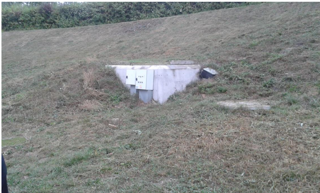
Obr.č.5 Armaturní šachta u atletického stadionu, slouží k uchovávání dešťové vody ze střechy bazénu
