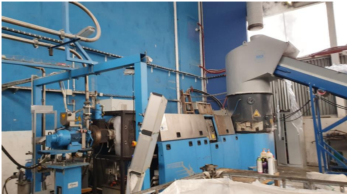
Obr. 6: Granulační linka ve společnosti AHV ekologický servis s.r.o.
