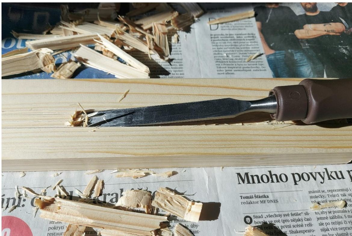
Obrázek 14 Tvorba drážky pro osvětlení
