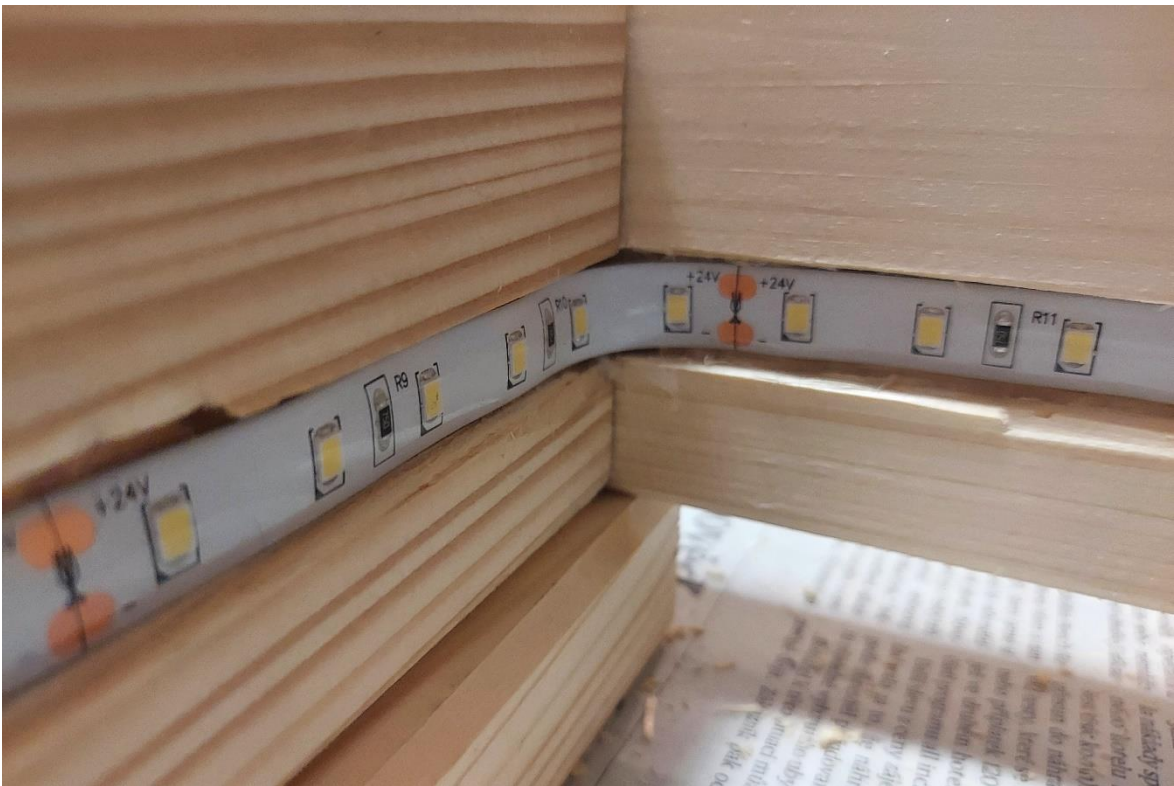
Obrázek 16 Instalace osvětlení
