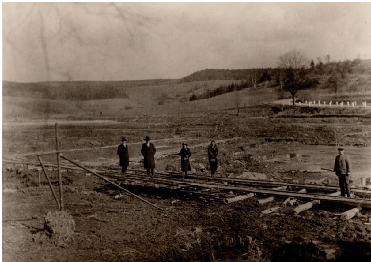
Obrázek 12: Stavba koupaliště v roce 1931.
