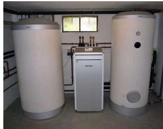
Obrázek 4/Tepelné čerpadlo země/voda [zdroj 6]
