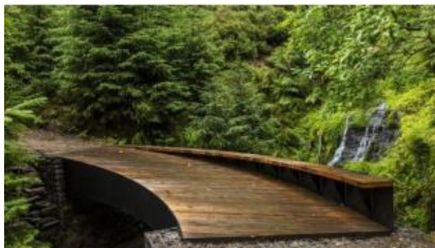
Obr. 7: Lávka přes Černou strouhu
