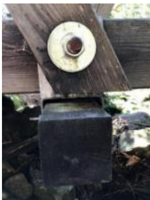
Obr. 3: Dřevěný styčník
