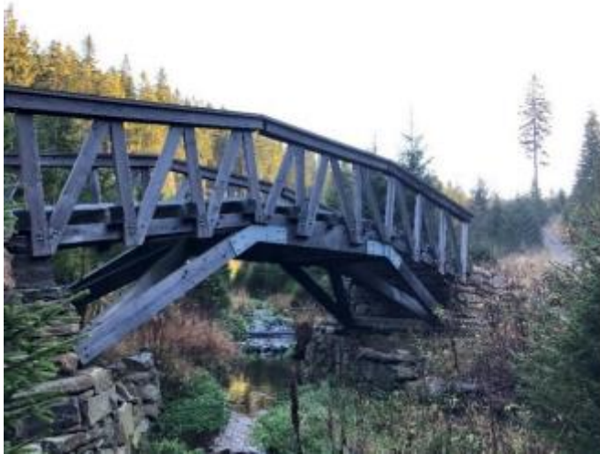
Obr. 1: Lávka přes Rennerův potok
