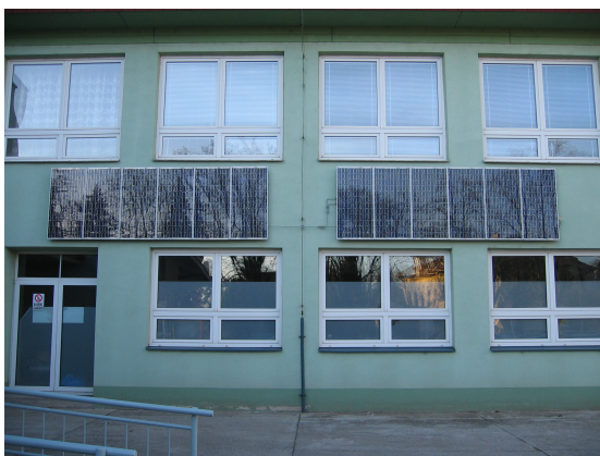
Obr. 2: Fotovoltaické panely na stěně budovy školy.
