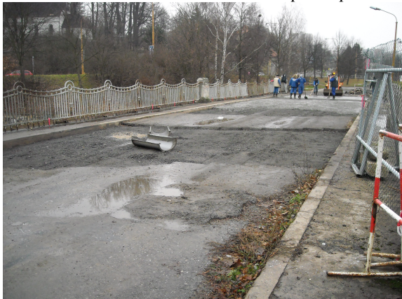
Oprava povrchu mostu – prosinec 2008
