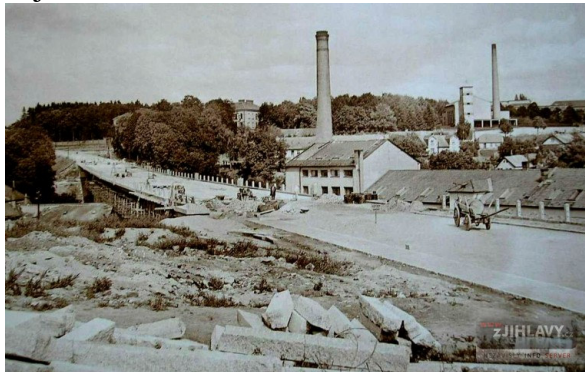
Stavba nového Brněnského mostu – rok 1956
