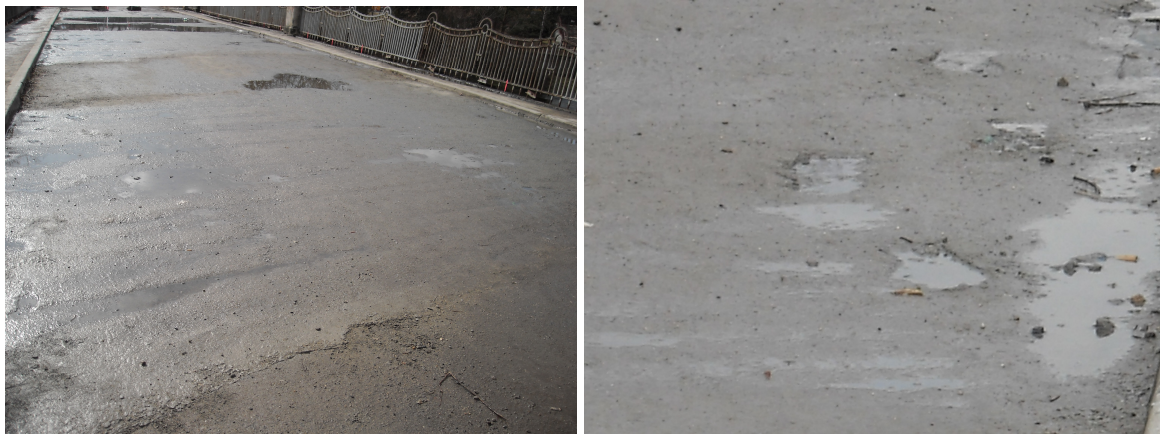
Opravený povrch mostu – březen 2009
