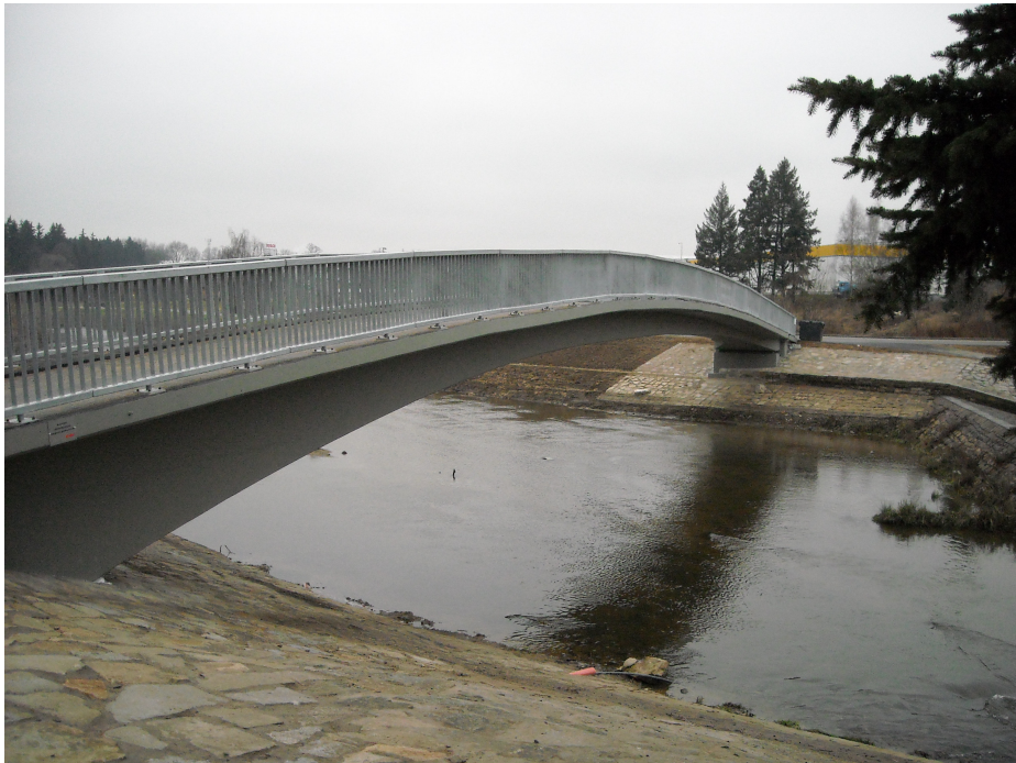
Lávka za obchodním domem Kaufland, slouží chodcům a její součástí je i cyklostezka.
