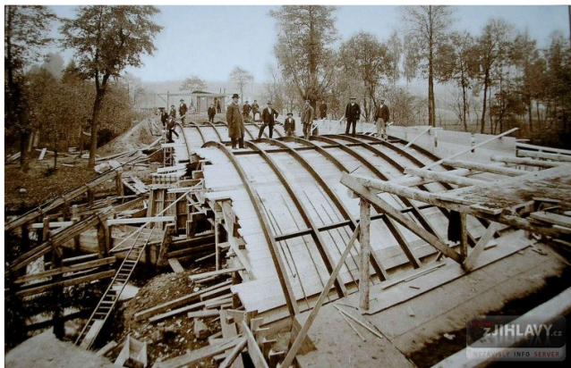
Foto ze stavby mostu – rok 1908
