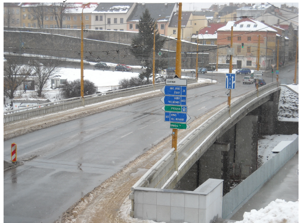
Pohled ze schodů nad ulicí U Dlouhé stěny
