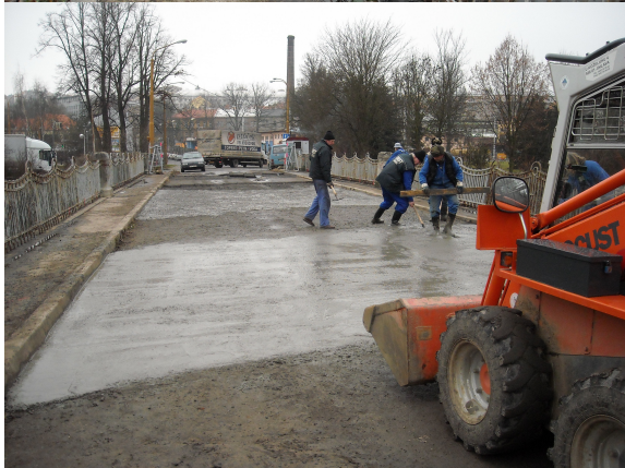
Oprava povrchu mostu – prosinec 2008
