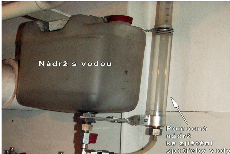
Obr. 3 Nádrž s vodou
