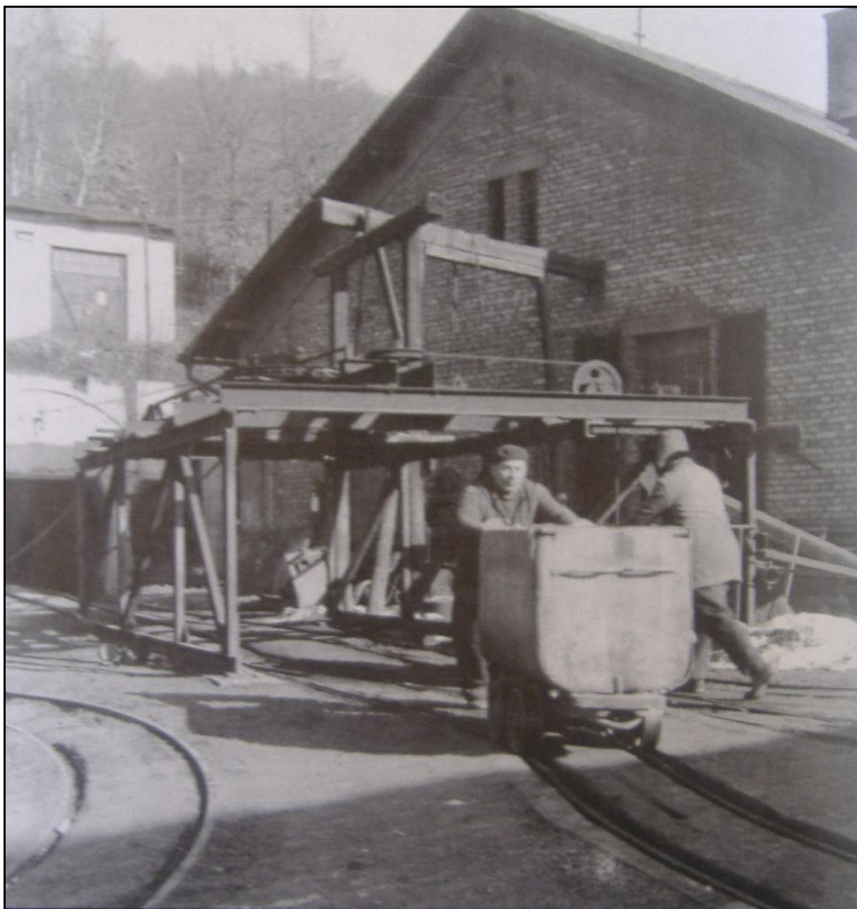
Obr. 3: Ruční doprava vozíků směrem k pražícím pecím
