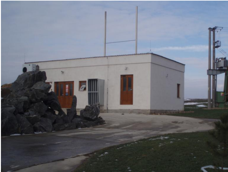
kogenerační místnost se dvěma motory o celkovém výkonu 500 KWh
