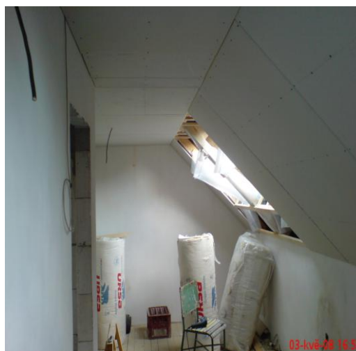
Zateplení střechy Orsilem
