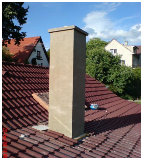
Nová střecha a komín vyšla na cca 100 000 Kč.
