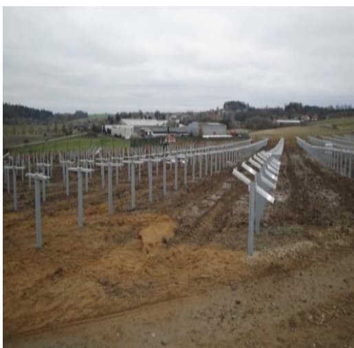
Rozestavěná sluneční elektrárna
