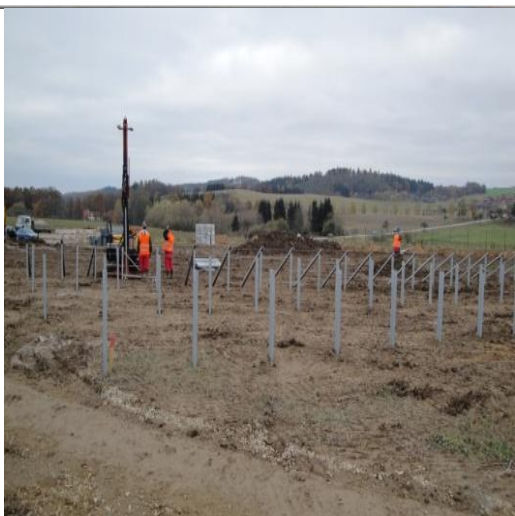
Rozestavěná sluneční elektrárna
