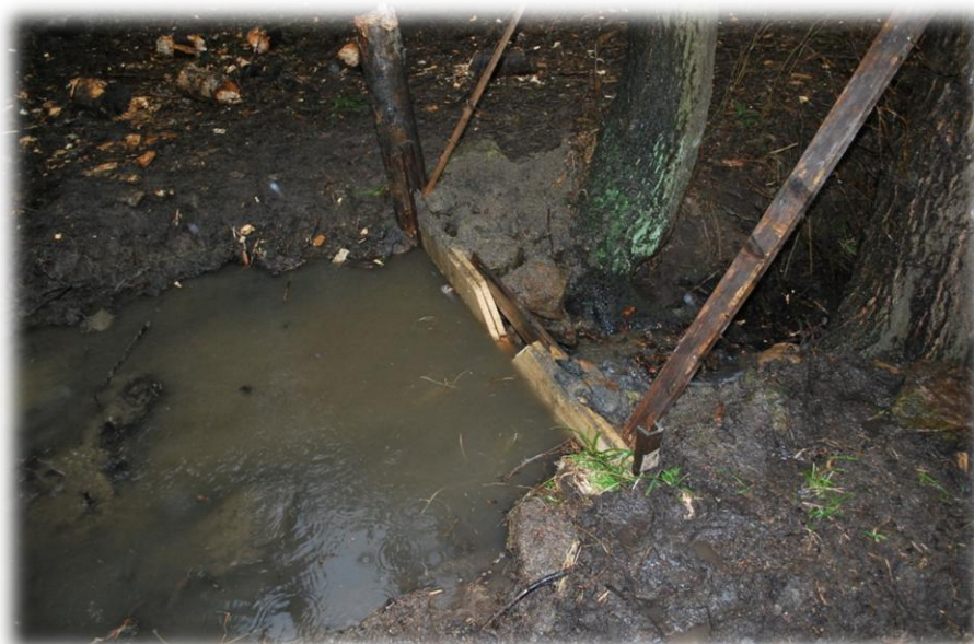
Obr. č. 36.: Hráz hned po dokončení prací
