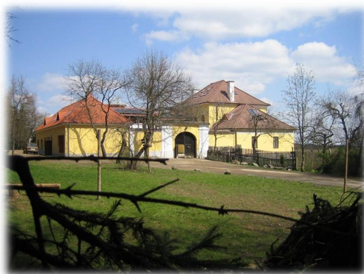
Obr. č. 2.: Budova Chaloupek
