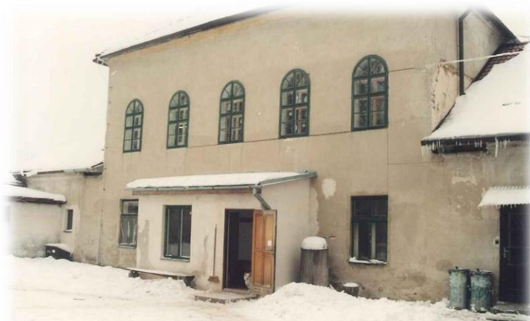
Obr. č. 6.: Chaloupky v zimě před rekonstrukcí
