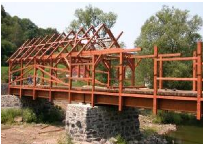
Obr. 37 - Výstavba dřevěné konstrukce - fotografie
