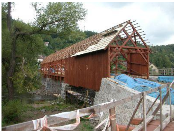
Obr. 45 - Realizace střešního pláště- fotografie
