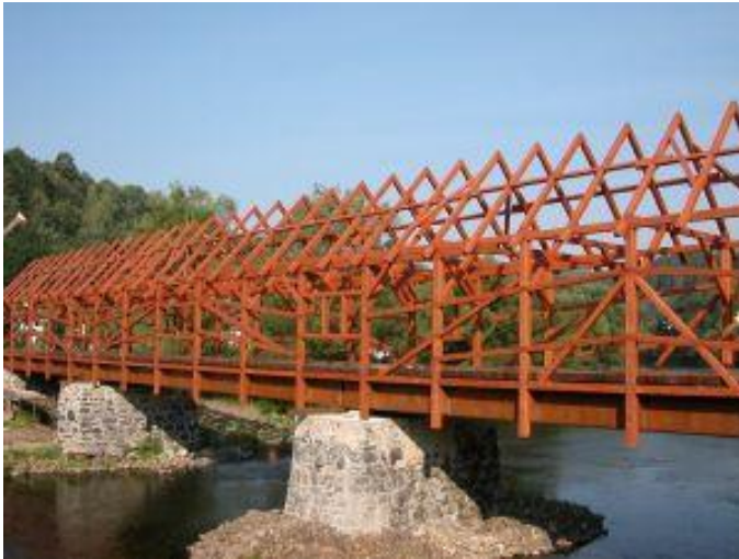
Obr. 40 - Dřevěná konstrukce - fotografie
