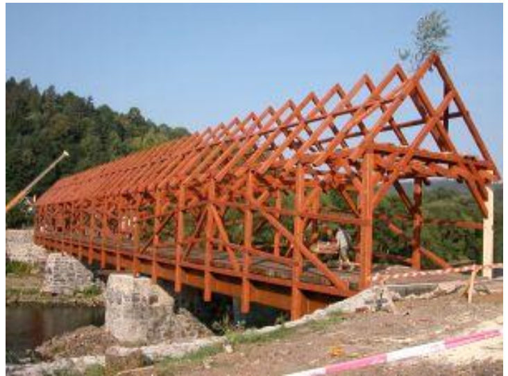
Obr. 41 - Dřevěná konstrukce - fotografie
