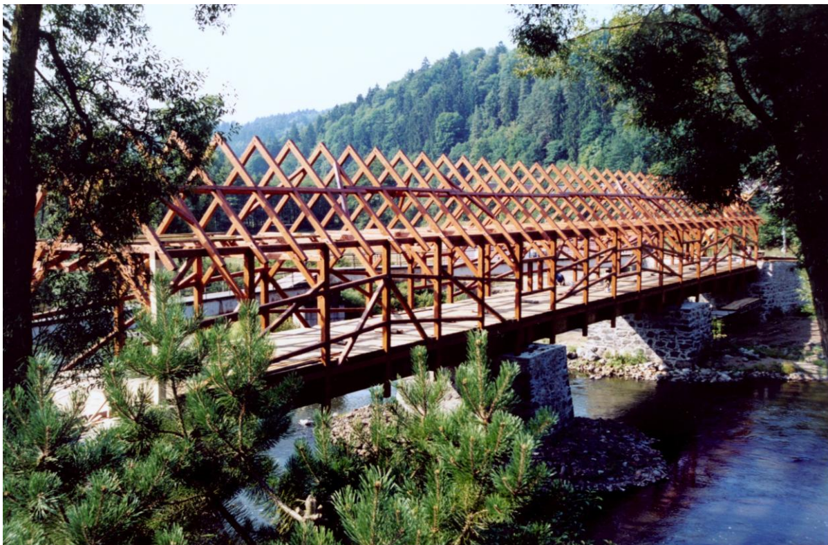
Obr. 43 - Dřevěná konstrukce - fotografie
