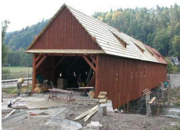
Obr. 47 - Dokončovací práce - fotografie
