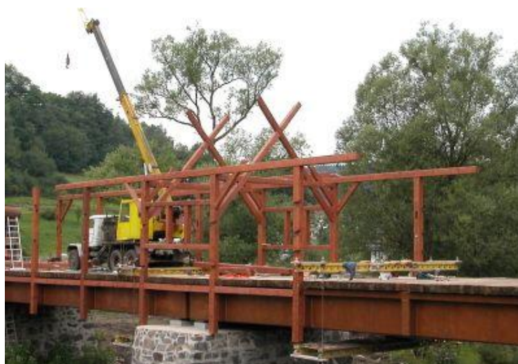
Obr. 38 - Výstavba dřevěné konstrukce - fotografie
