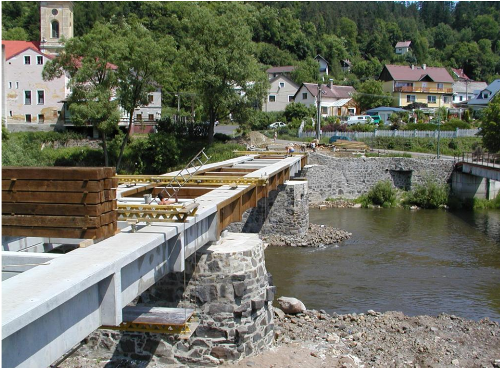
Obr. 30 – Montáž dřevěného obložení - fotografie
