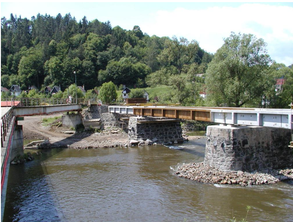
Obr. 31 – Pohled na nosnou konstrukci - fotografie
