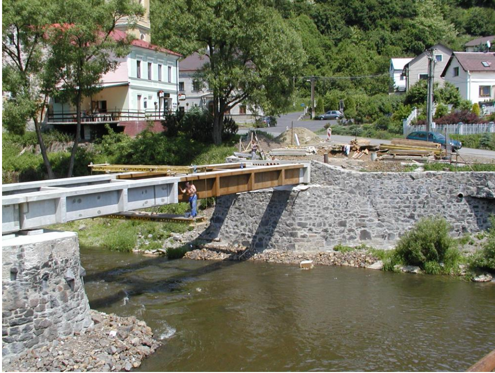
Obr. 32 – Pohled na nosnou konstrukci - fotografie
