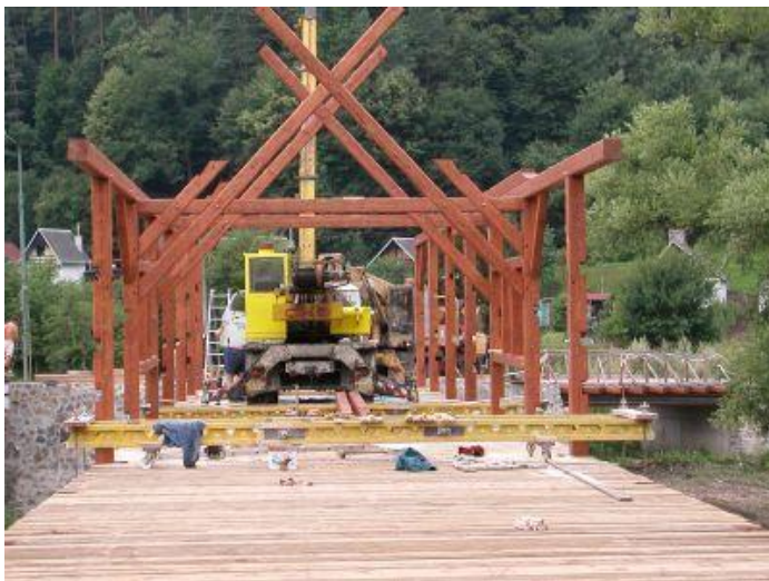
Obr. 36 - Výstavba dřevěné konstrukce - fotografie
