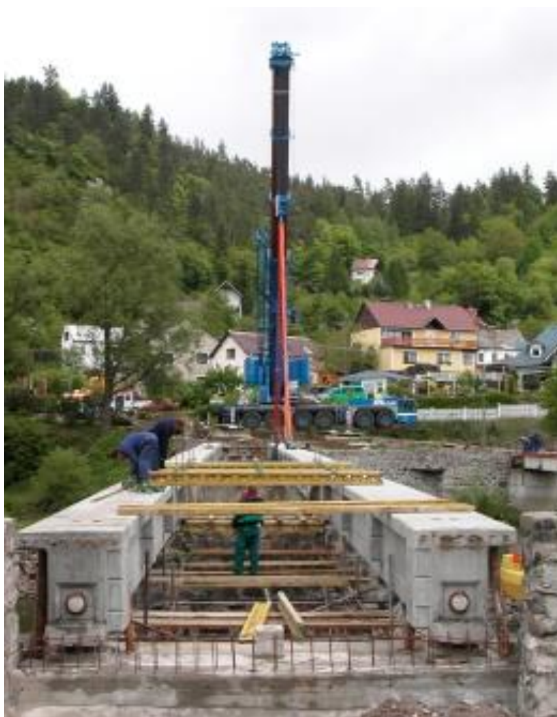
Obr. 29 – Ukládání železobetonových nosníků - fotografie
