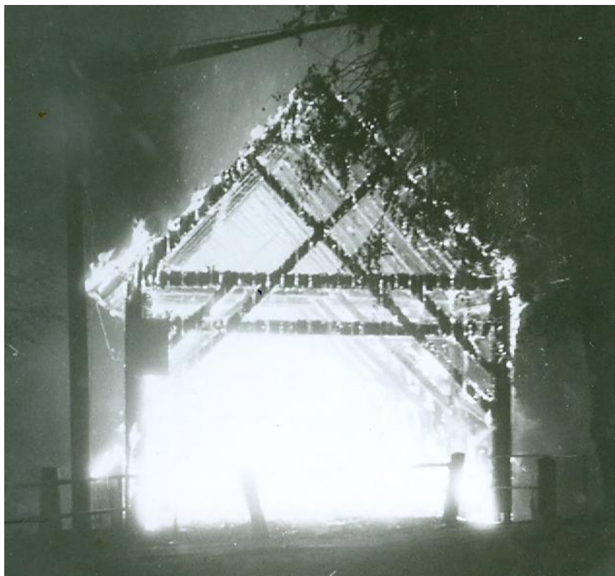
Obr. 7 – Hořící radošovský most - fotografie
