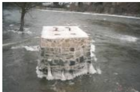
Obr. 28 – Pilíř dokončený - fotografie
