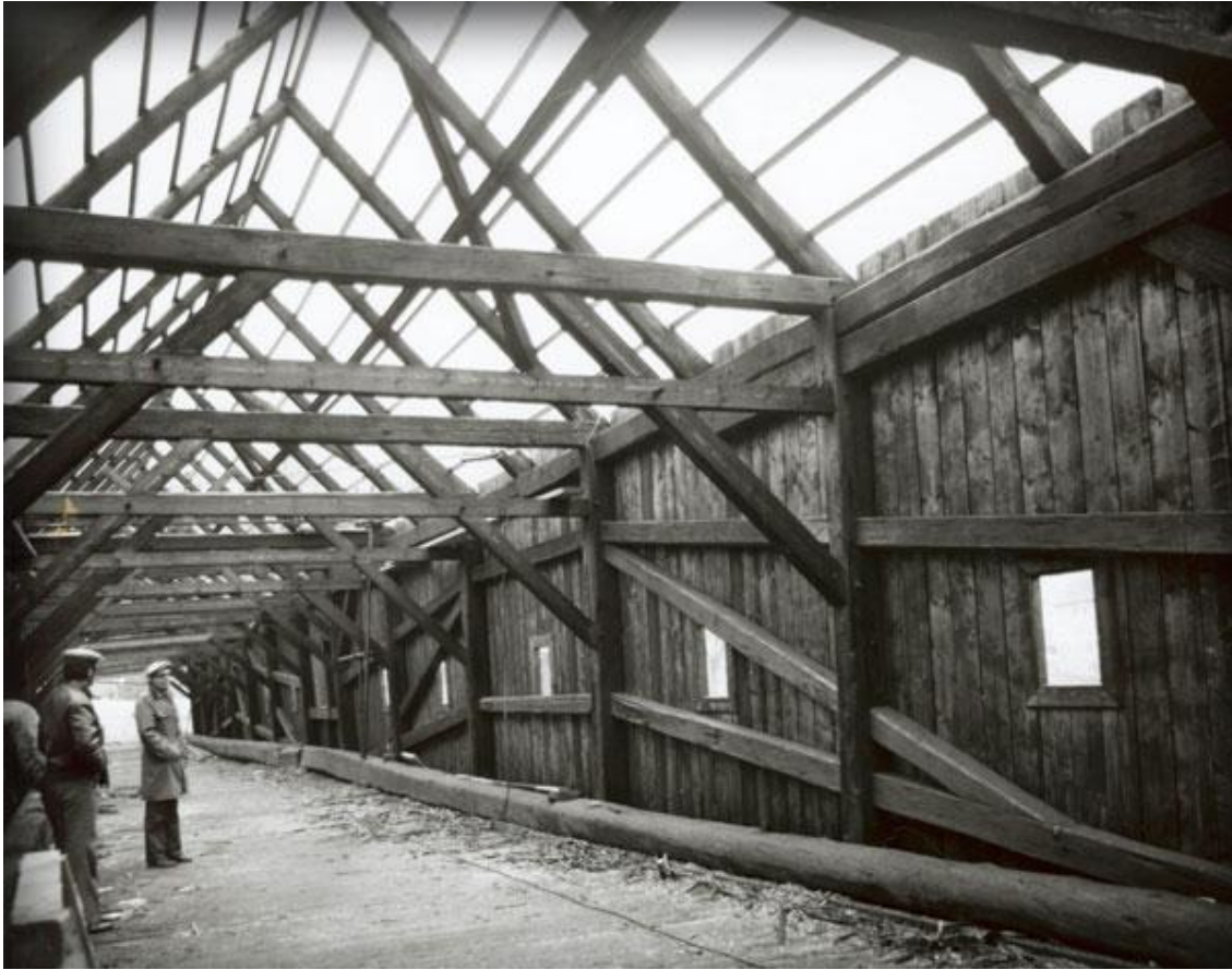
Obr. 15 – Radošovský most před požárem - fotografie
