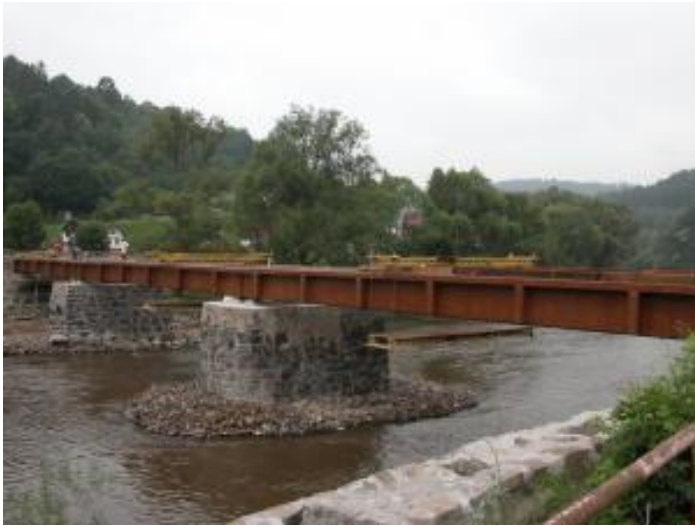
Obr. 34 – Pohled na dokončené obložení nosníků - fotografie
