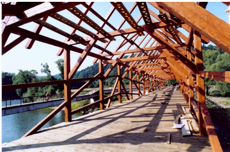
Obr. 42 - Dřevěná konstrukce - fotografie
