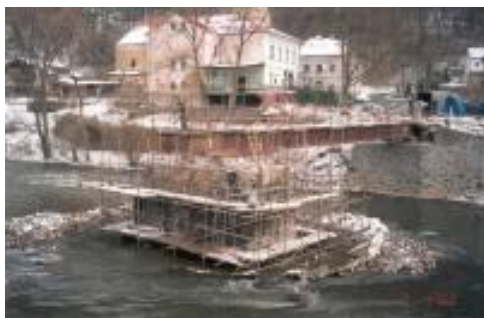
Obr. 27 – Výstavba pilíře - fotografie
