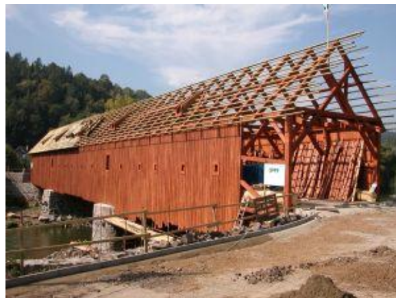
Obr. 46 - Realizace střešního pláště- fotografie
