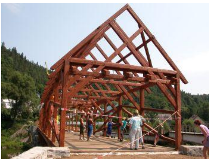
Obr. 39 - Dřevěná konstrukce - fotografie
