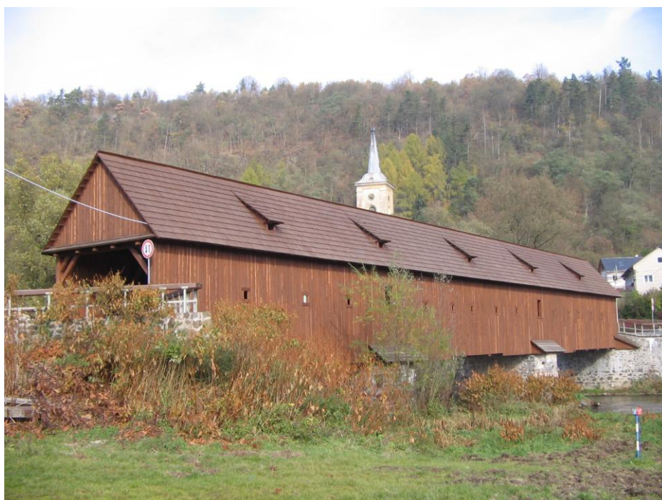
Obr. 49 - Dokončená obnova - fotografie
