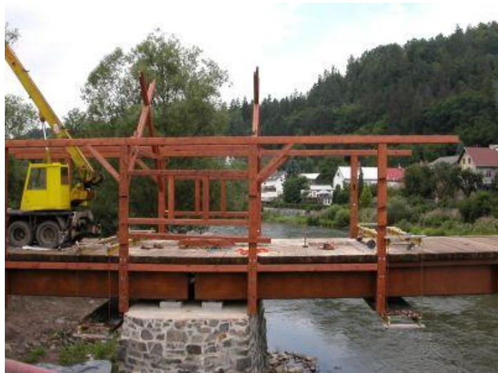
Obr. 35 – Výstavba dřevěné konstrukce - fotografie
