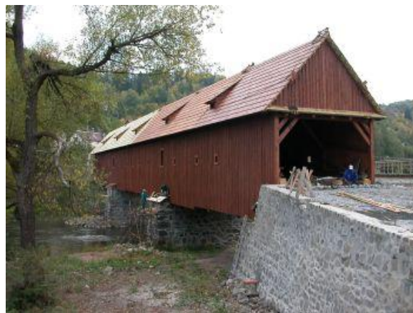
Obr. 48 - Dokončovací práce - fotografie
