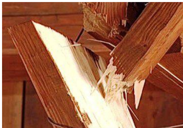
Obr. 20 – Radošov poškození automobilem - fotografie
