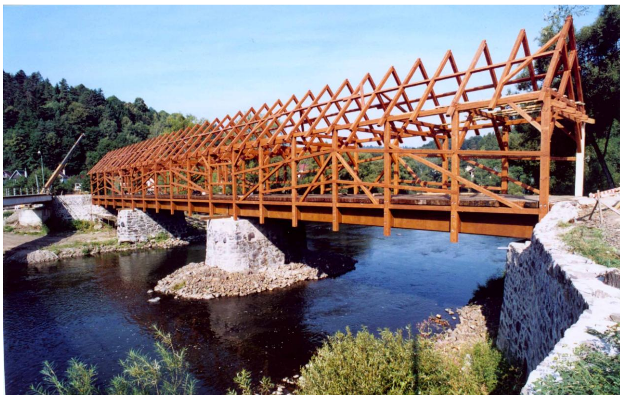
Obr. 44 - Dřevěná konstrukce - fotografie
