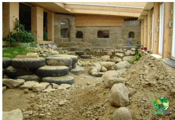
Obr. 26 Rozestavěná zemělod' ve Švédsku, na mapě na následující straně označena Z2 ▼.
