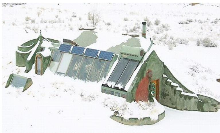
Obr. 7 Zeměloď jsou stavěny i v oblastech, kde se v zimě pohybuje teplota kolem - 50°C.
