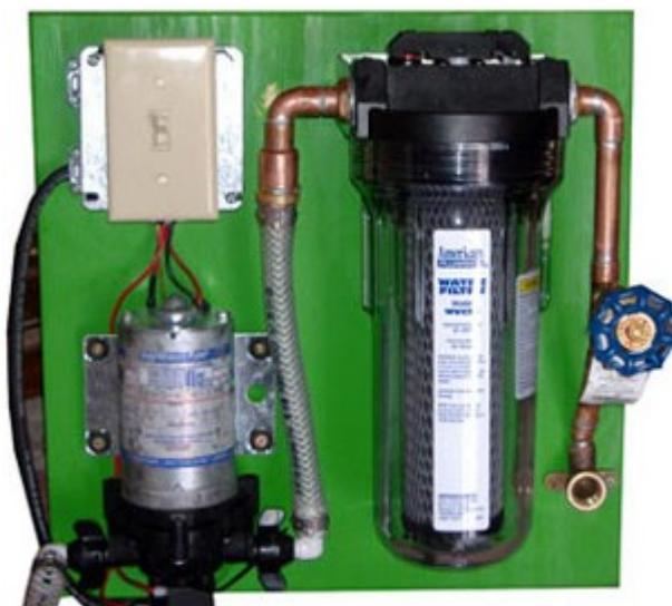
Obr. 14 Zařízení, které pumpuje použitou vodu na splachování záchodu.
