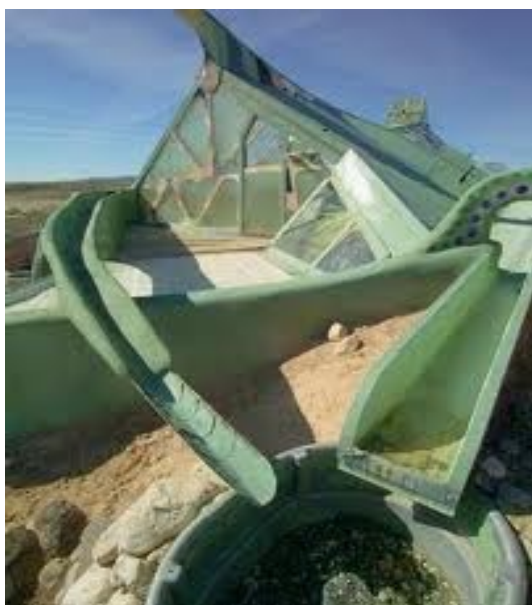
Obr. 10 Přívod vody ze střechy do cisterny.
