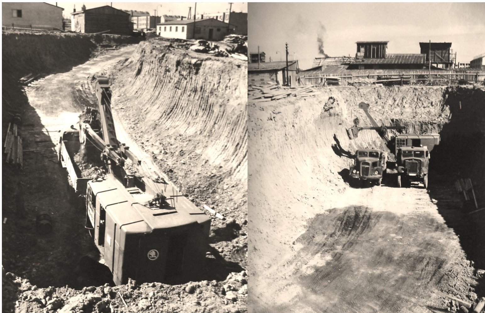
Lžicové rypadlo Škoda při výkopech.
