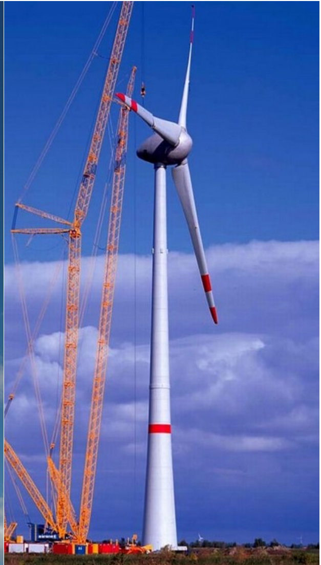
Obr.17: stavba Enercon E-126/ 7,5MW
