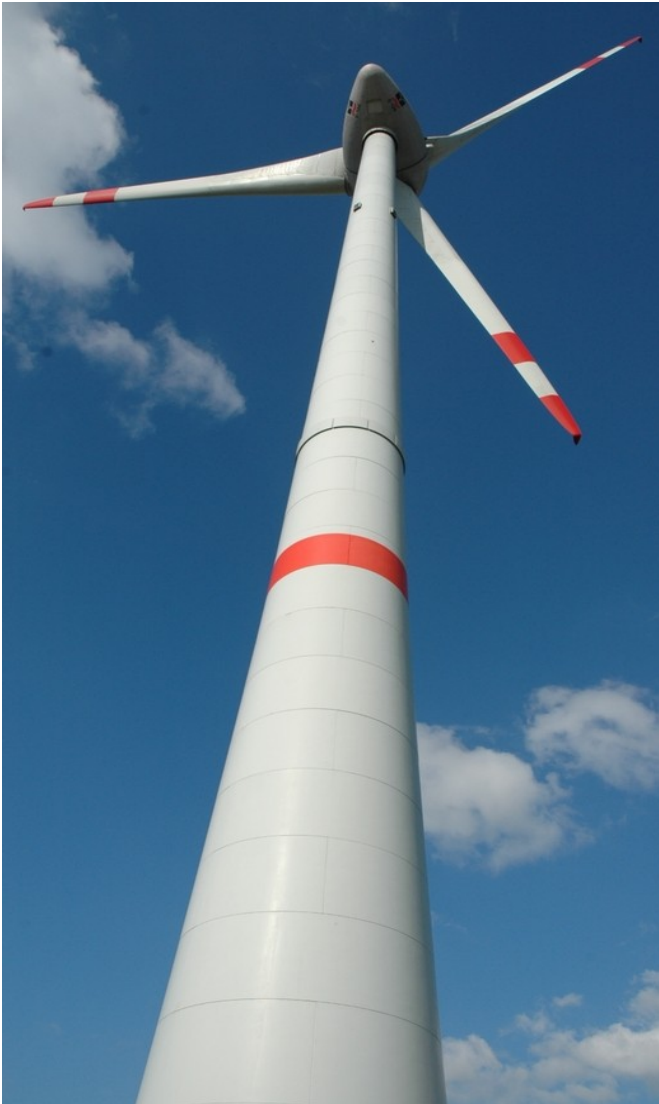
Obr.16: Enercon E-126/ 7,5MW
