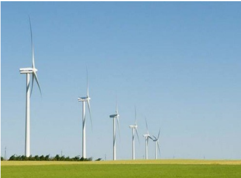
obrázek č. 18 - větrné elektrárny s převodovkou
