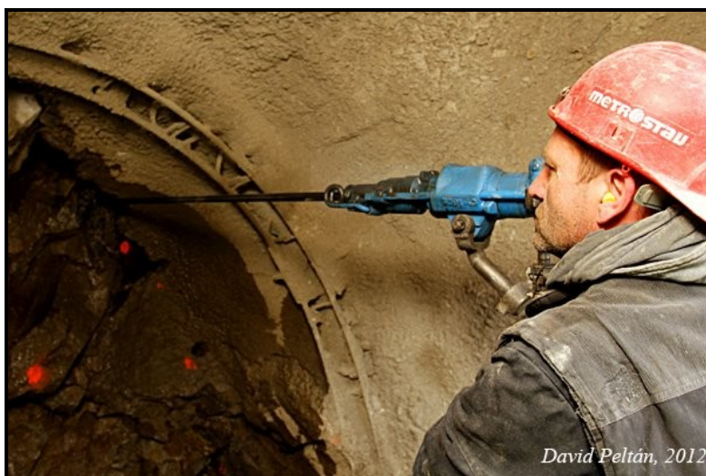
Obr. 2 Budování spodní výpusti
