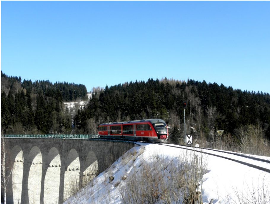
Obrázek č. 4 – 642 na Smržovském viaduktu Zdroj: autor
