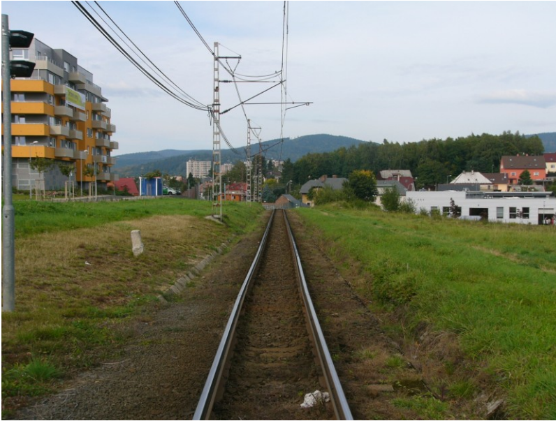
Obrázek č. 23 – úzká řetězovka, zesilovací vedení trolejového vedení (kvůli úbytkům napětí ve vedení) Zdroj: [3]
