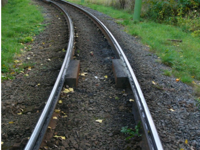
Obrázek č. 18 - Stabilní tukové mazání okolků na trati, ke snížení opotřebení kol a kolejnic. Zdroj: [3]
