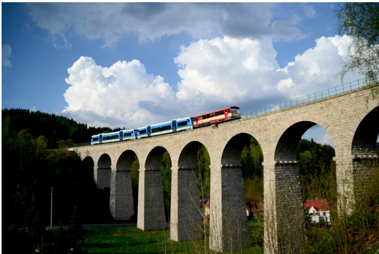
Obrázek č.14 – souprava 810 + 2x840 na Smržovském viaduktu Zdroj: [1]
