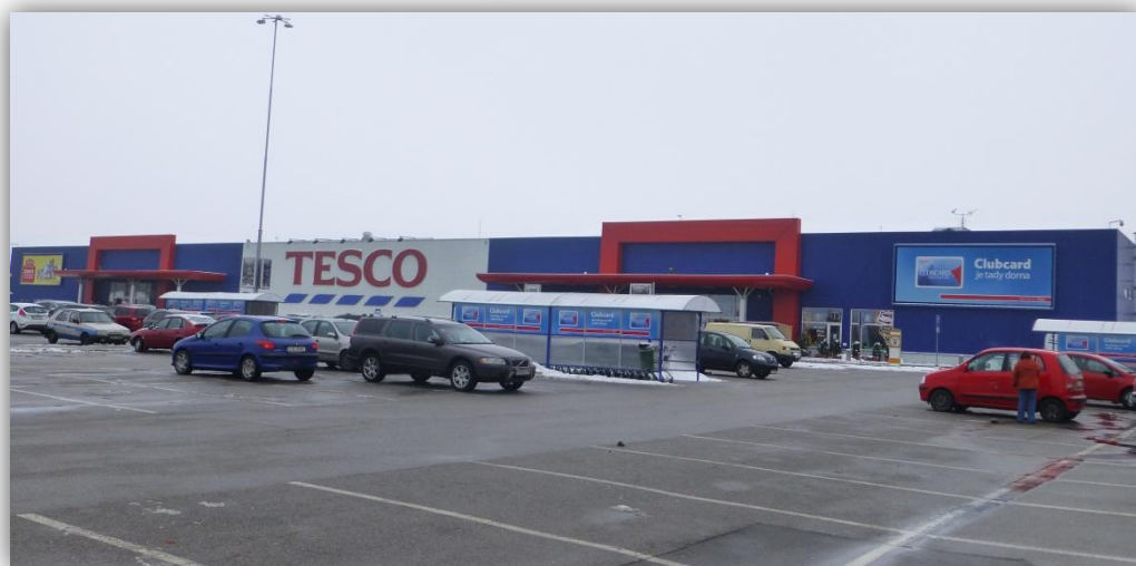
Obr. 3 Tesco Stores ČR, a.s. Brněnská 4971/74
