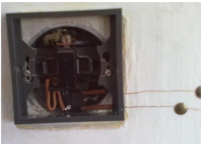
Obr. 7: Instalace relé do vypínače na stěně
