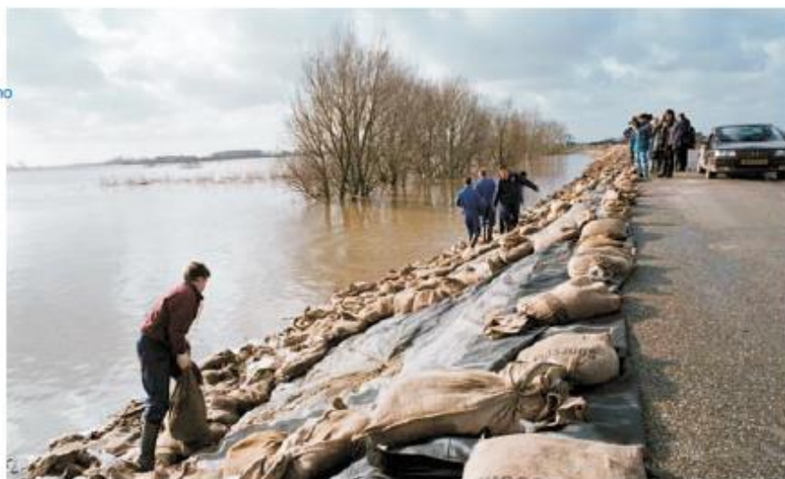
Foto: Nouzové opravy s pískovými pytlíky na "Otchen" při povodních v roce 1996. Zdroj: Rijkswaterstaat
