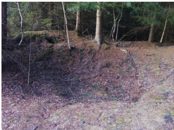
Zasypaná šachta na vrchu Hůrka
