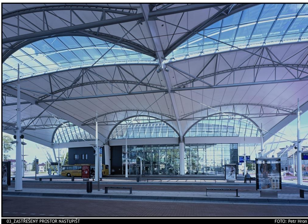
obr. 10: Využití membránového zastřešení na terminálu MHD Hradce Králové
