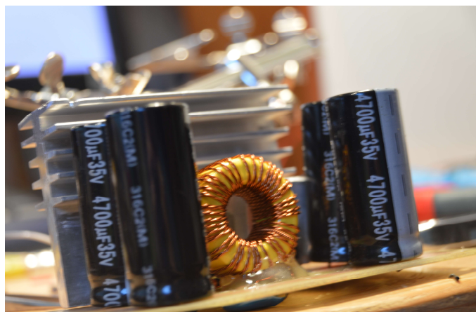
Obr. 13 – Foto výkonové části
