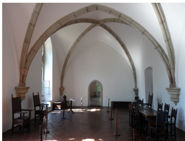
obr. 27 – Hrad Zvíkov. Křížová klenba s konzolami
