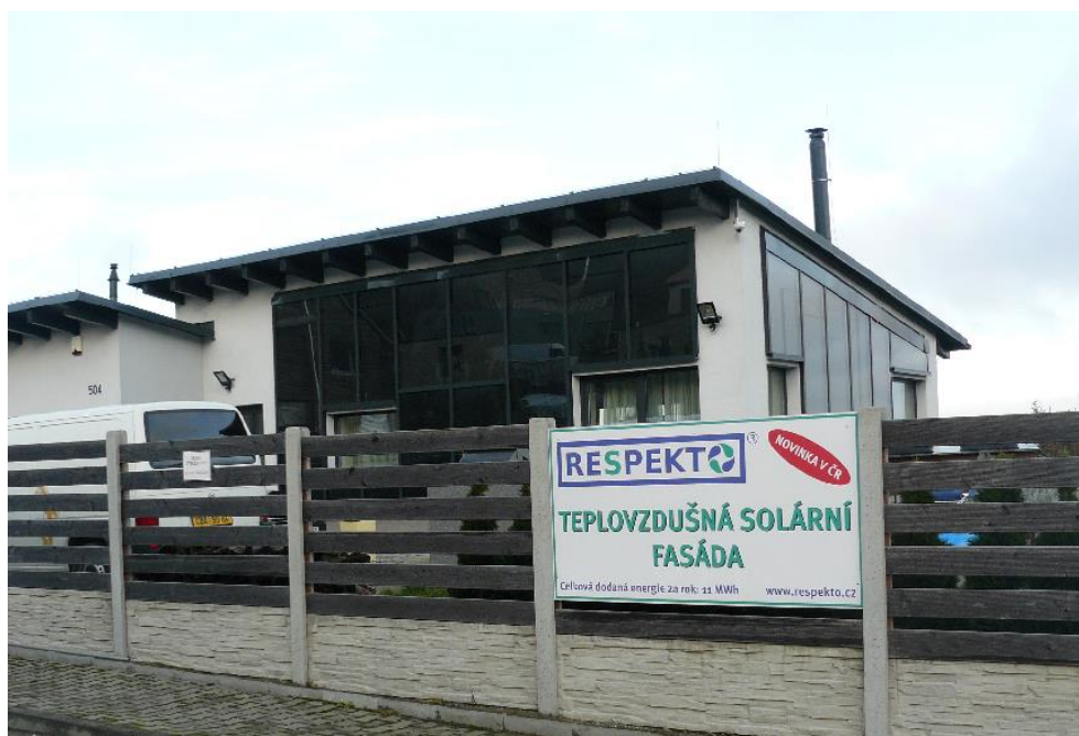
Obr. 13: Teplovzdušná solární fasáda na rodinném domě na svahu Ještědu [foto autor]
