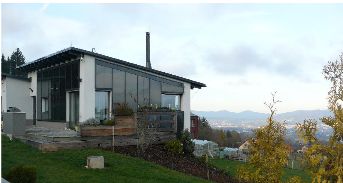
Obr. 14: Pohled na objekt se solární fasádou od jihozápadu a krásný výhled na Liberec
