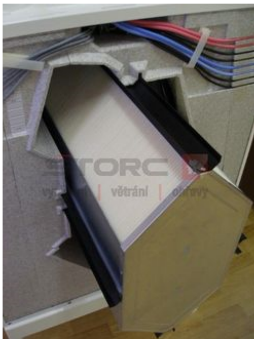
Obr. 10: Větrací jednotku Renovent Excellent je možné pořídit s entalpickým výměníkem [6]
