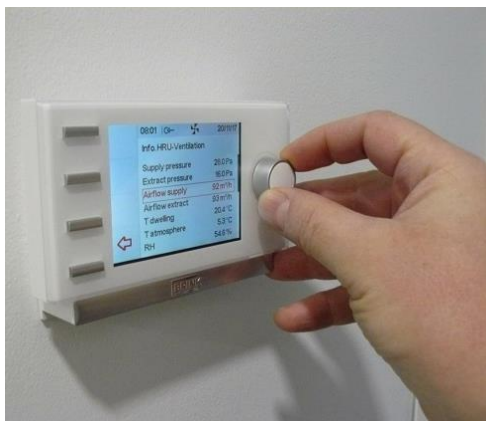
Obr. 14: Ovladač Brink Air kontrol - programovatelný ovladač se zobrazením aktuálních provozních hodnot [2]
