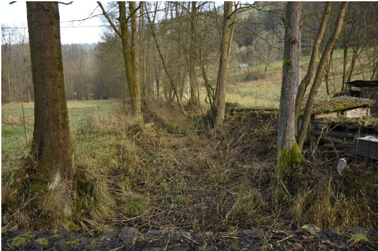
Obrázek 6 Přivaděcí kanál před rekonstrukcí, Foto autor
