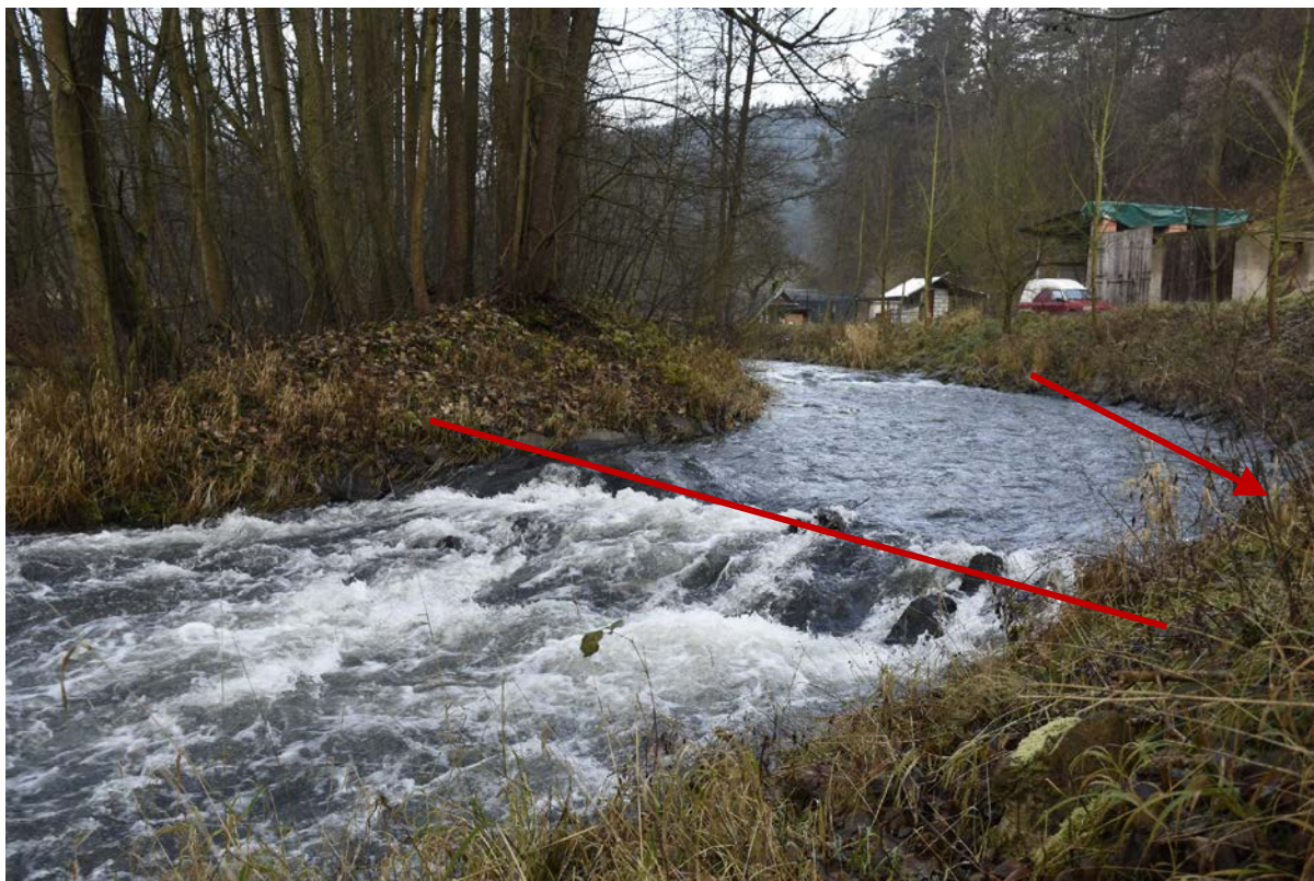
Obrázek 5 Čarou je vyznačeno, umístění nového jezu. Šipkou vtok do přiváděcího kanálu, Foto autor
