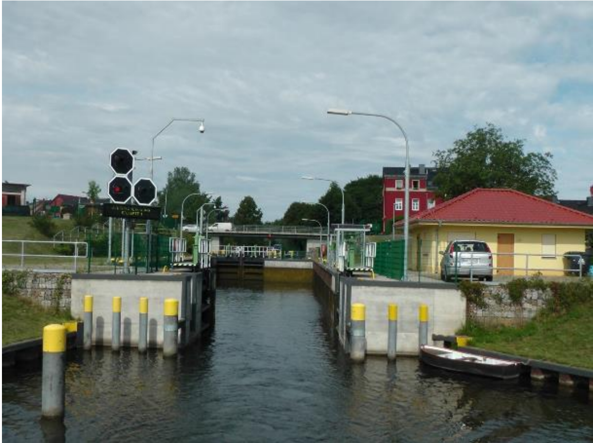
Obrázek 19 Automatické zdymadlo, pohled z dolní rejdy
