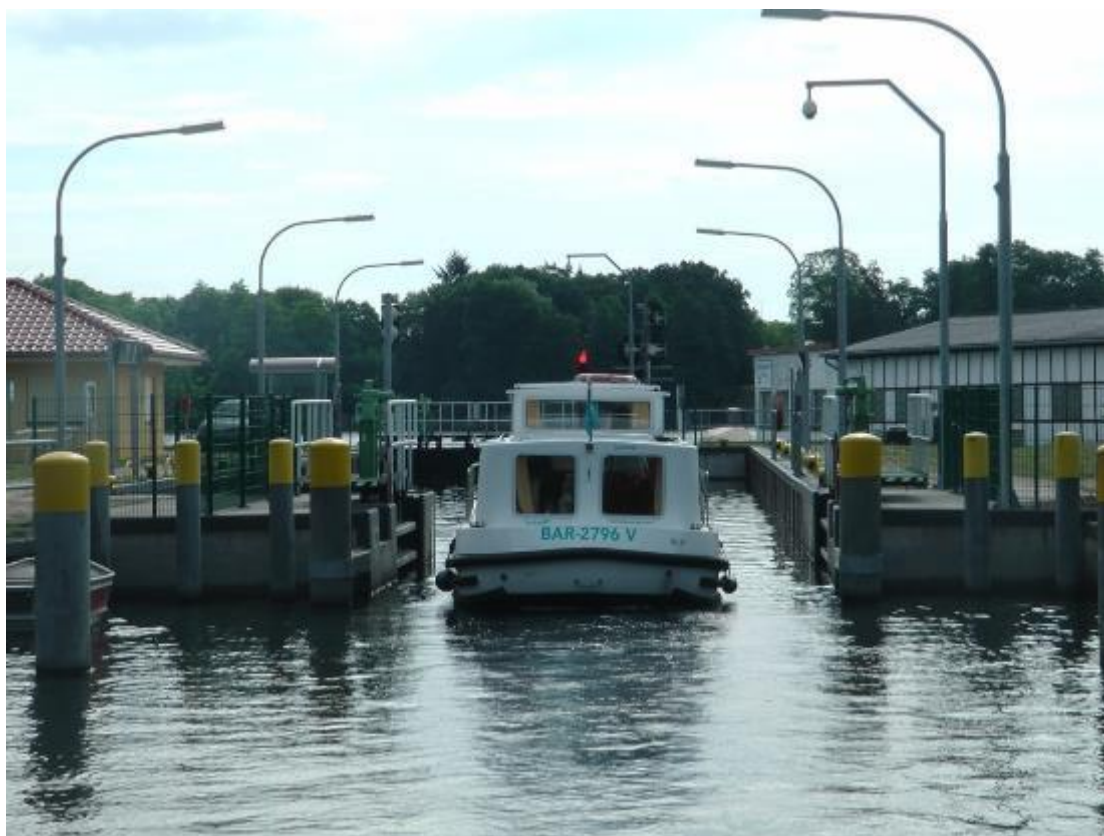
Obrázek 17 Automatické zdymadlo, pohled z horní rejdy
