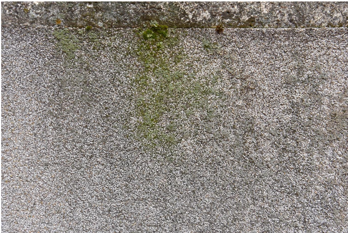
Obrázek 4: Zelená řasa na cementovém podkladu
