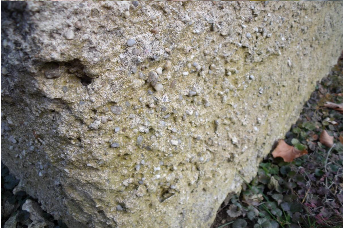
Obrázek 9 a 10: Kolonizace kamenných podkladů lišejníky, mechorosty a řasami
