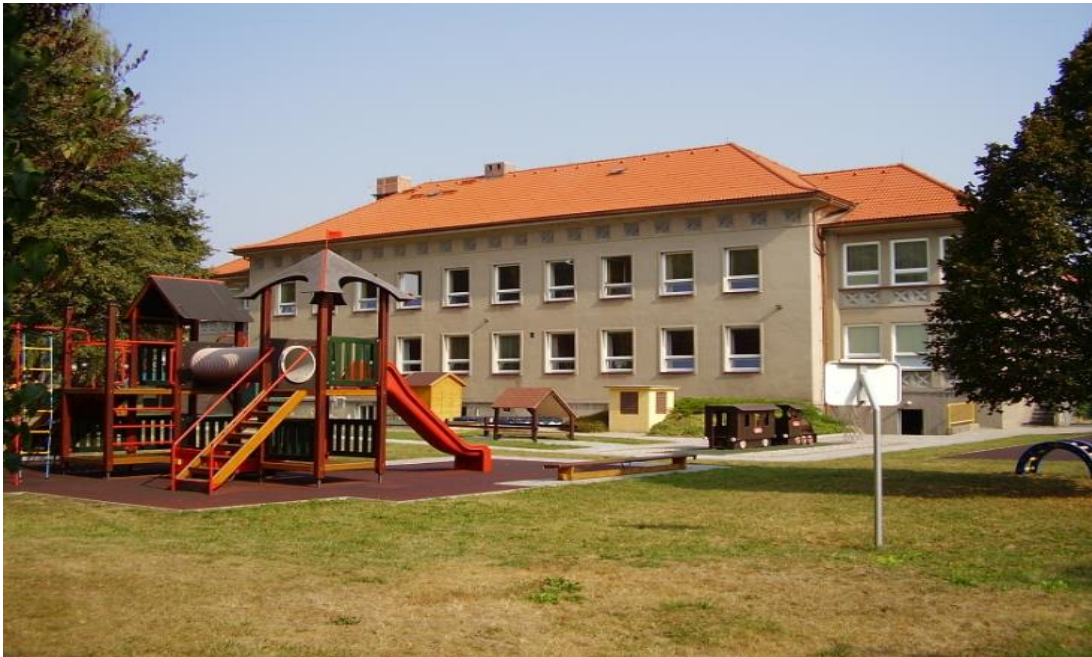
obrázek č.4 stávající objekt
